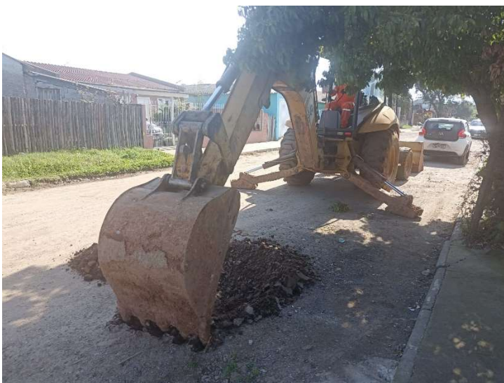
Figura 2: escavação de Poço de Inspeção 02 - Rua “G”.
