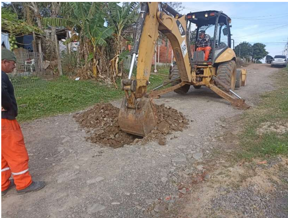
Figura 4: escavação de Poço de Inspeção 02 - Rua das Tainhas.
