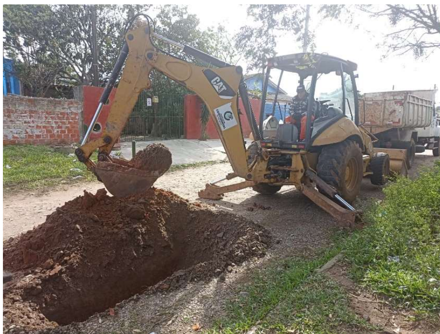
Figura 7: escavação de Poço de Inspeção 03 - Rua das Carpas.
