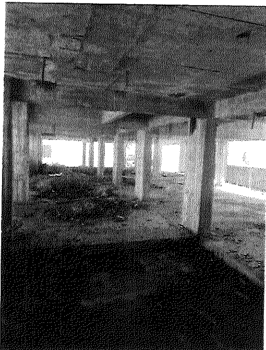
Detalhe – estrutura da parte com frente para Rua Dr. Francisco Mariano da Rocha
