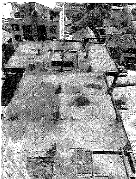
Detalhe – cobertura da parte com frente para Rua Dr. Francisco Mariano da Rocha
