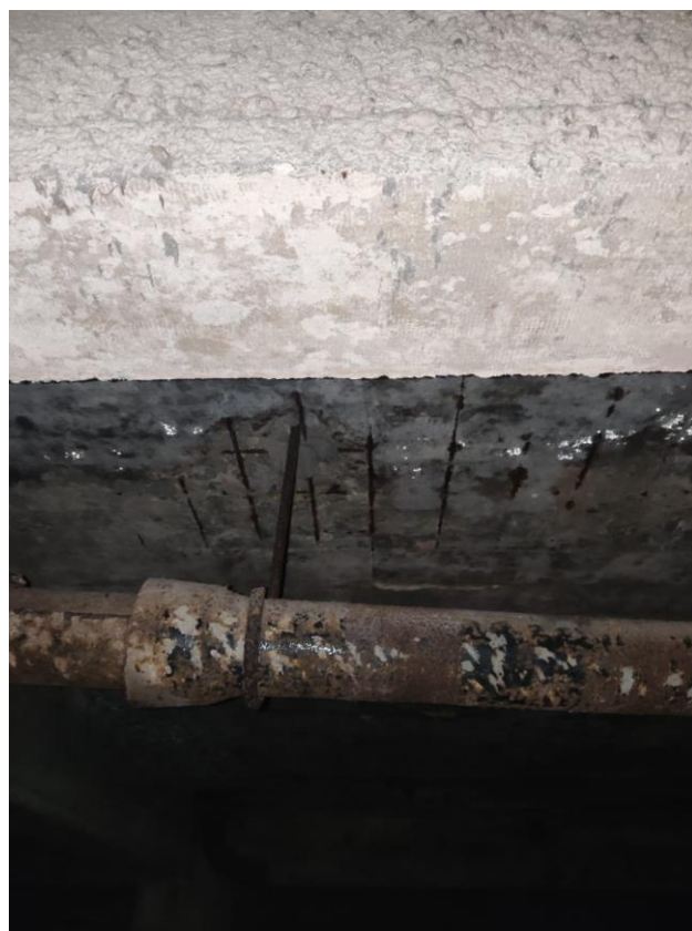
Foto 24 – Armadura de laje afetada lixiviação do concreto. Tipo a
