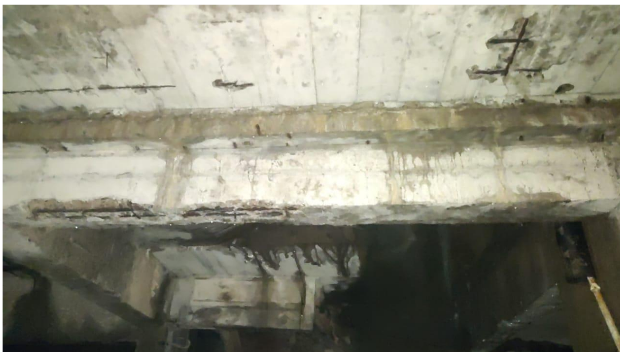
Foto 14 – Armadura na face inferior da viga exposta. Tipo b
