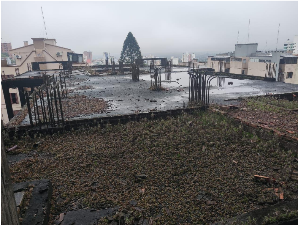
Foto 01 – Armadura de espera em bom estado no Bloco dos Fundos
