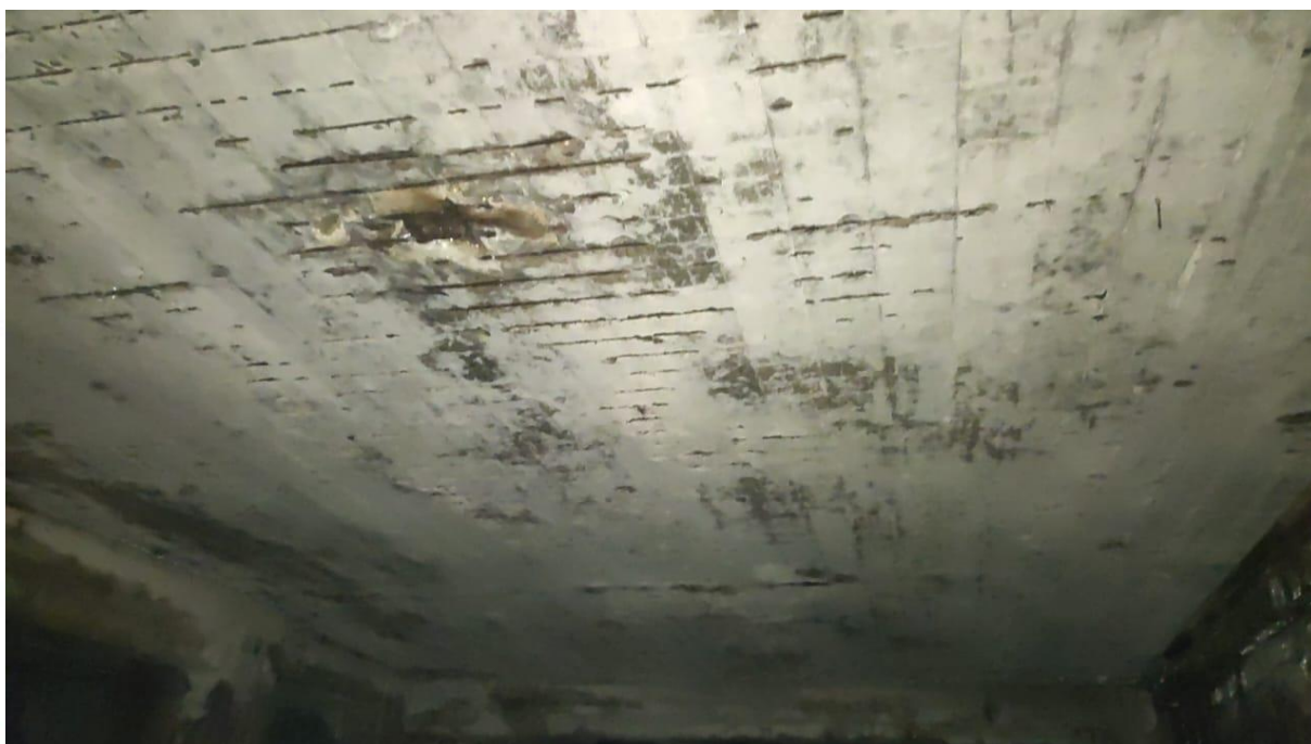
Foto 18 – Significativa armadura da laje afetada, mas com orientação em uma mesma direção. Tipo a.
