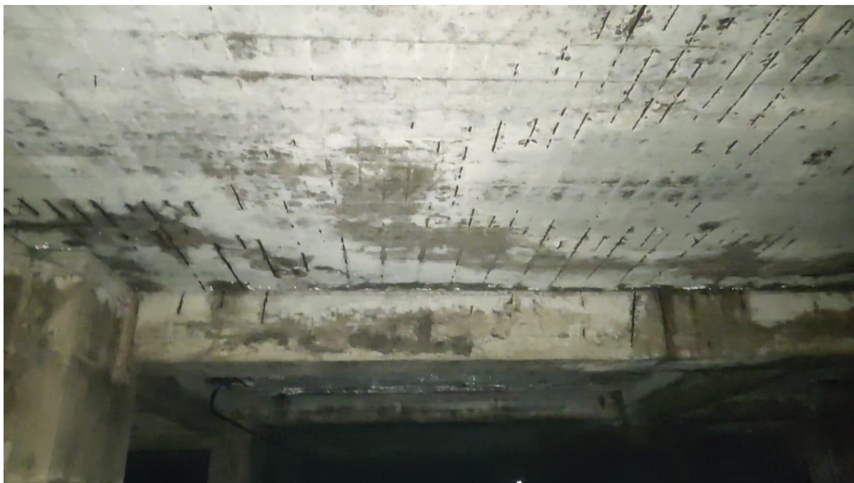
Foto 17 – Armadura exposta numa mesma direção. Tipo a
