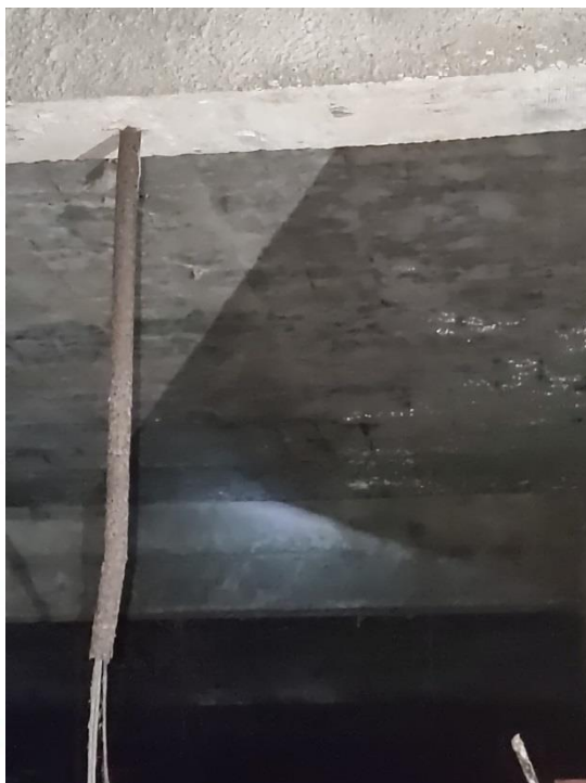
Foto 30 – Lixiviação da laje Tipo a
