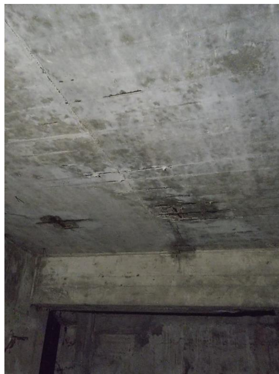
Foto 02 – Armadura afetada em uma pequena região. Tipo a
