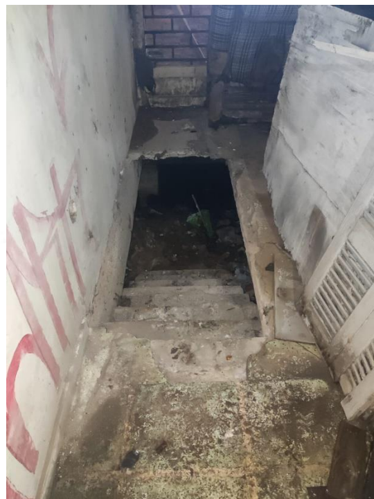
Foto 33 – Escada fora de projeto parcialmente desobstruída para acessar o subsolo.
