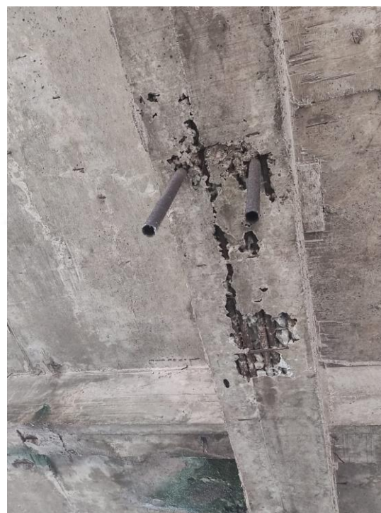
Foto 10 – Ninho de concretagem. Tipo e.
