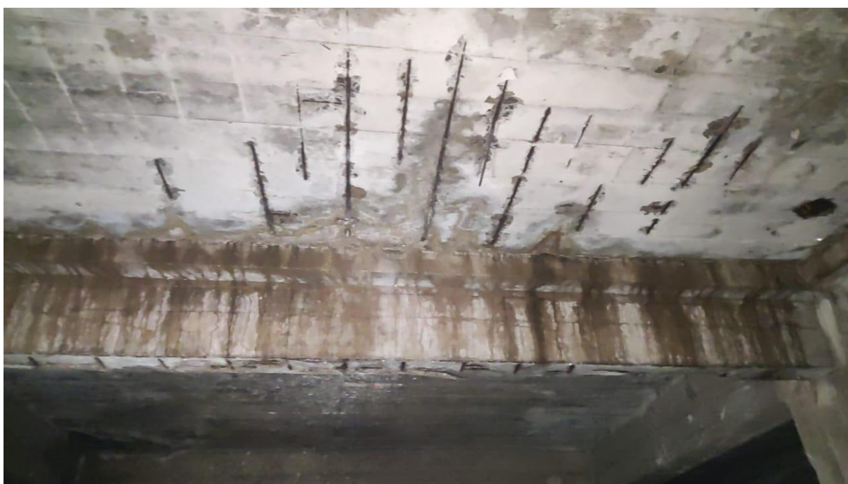
Foto 15 – Significativa armadura da laje afetada, mas com orientação em um mesmo sentido. Tipo a. Na viga Tipo b
