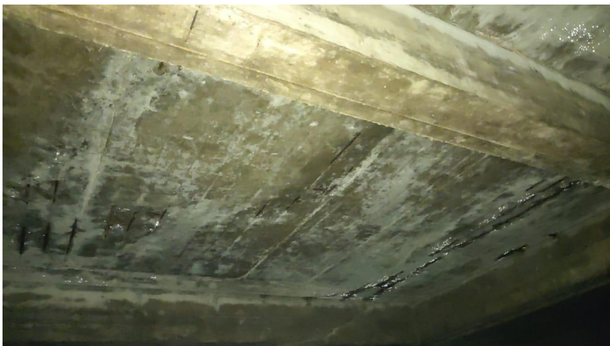
Foto 06 – Armadura da laje afetada em duas regiões, mas com orientação em um mesmo sentido. Tipo a.
