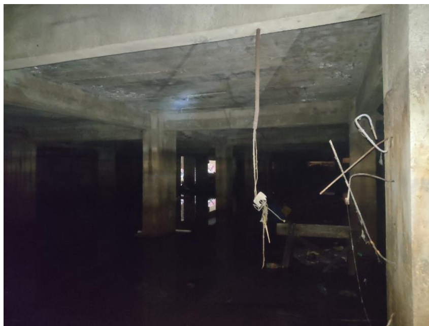
Foto 25 – Laje com apenas umidade e lixiviação sem armadura afetada significativamente. Tipo a
