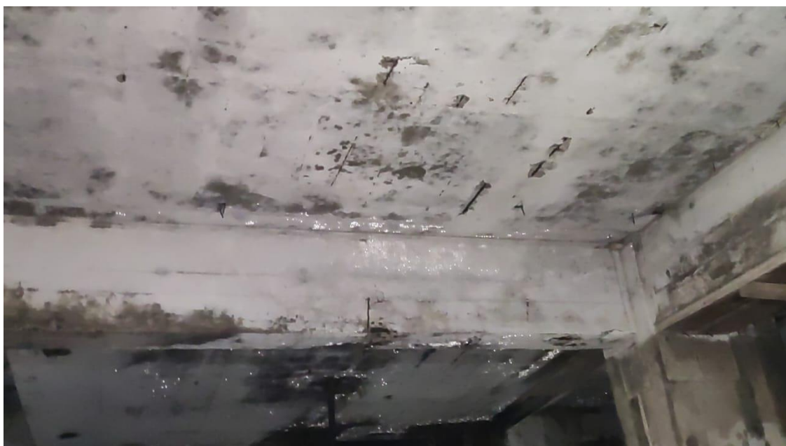
Foto 08 – Pouca armadura da laje afetada. Tipo a.
