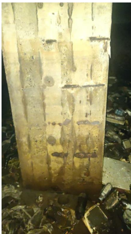
Foto 01 – P39 com leve oxidação dos estribos. Tipo c
