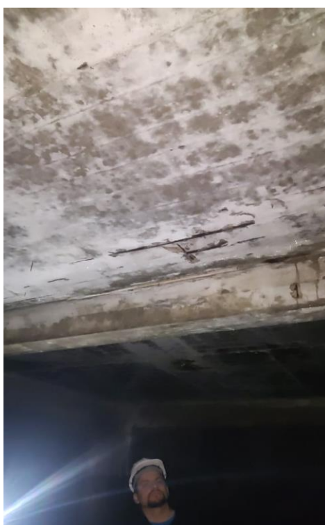
Foto 05 – Armadura da laje – Tipo a - e da viga Tipo b - afetadas em uma pequena região.
