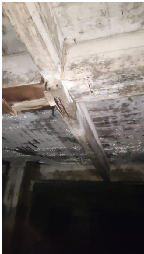
Foto 09 – Restos de madeira da forma e armaduras afetadas na ligação das vigas. Tipo b
