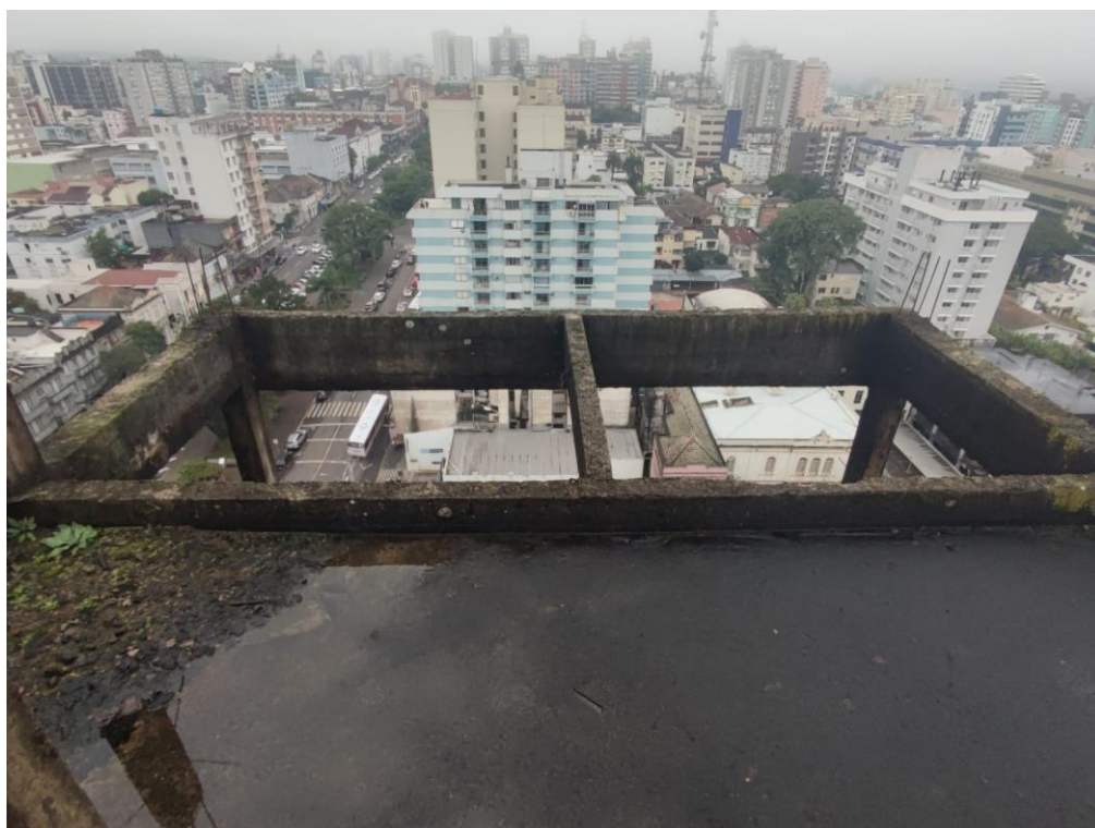
Foto 06 – Poço do elevador em estado recuperável.
