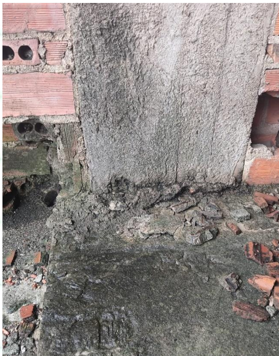
Foto 02 – P01. Ninho de concretagem. Tipo e
