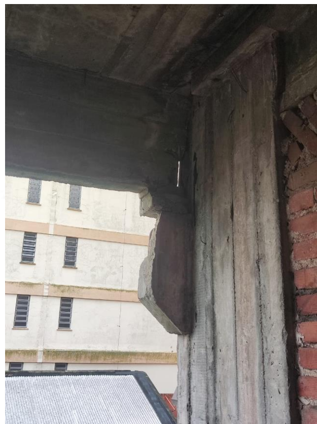
Foto 08 – P55. Dente deteriorado. Tipo d
