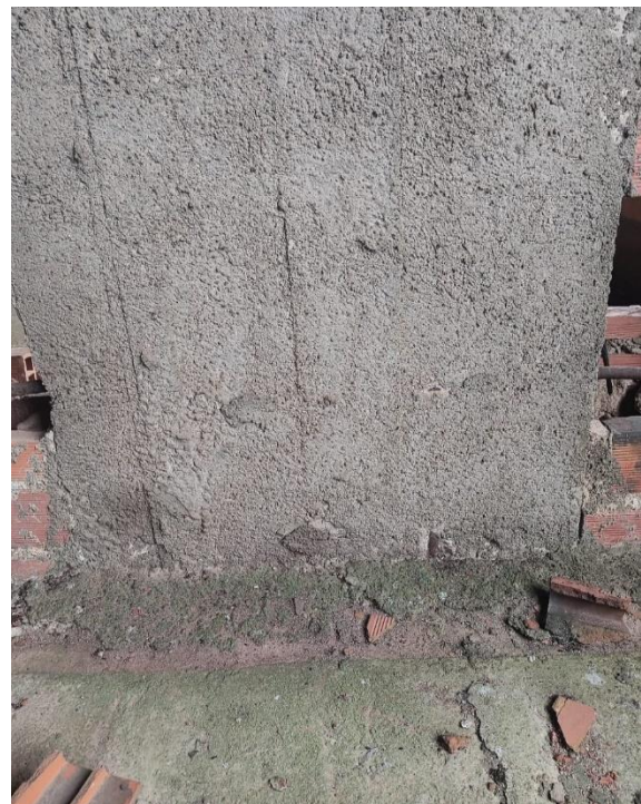
Foto 03 – P31. Ninho de concretagem. Tipo e
