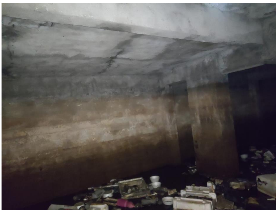
Foto 28 – Boa condição dos pilares e vigas no subsolo
