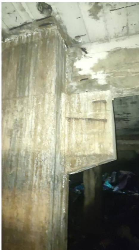
Foto 16 – Junta de dilatação em bom estado de conservação.
