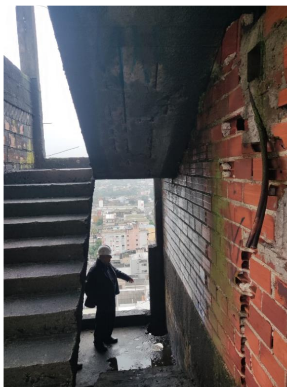
Foto 12 – Escada. Tipo a. Redução da seção do pilar.
