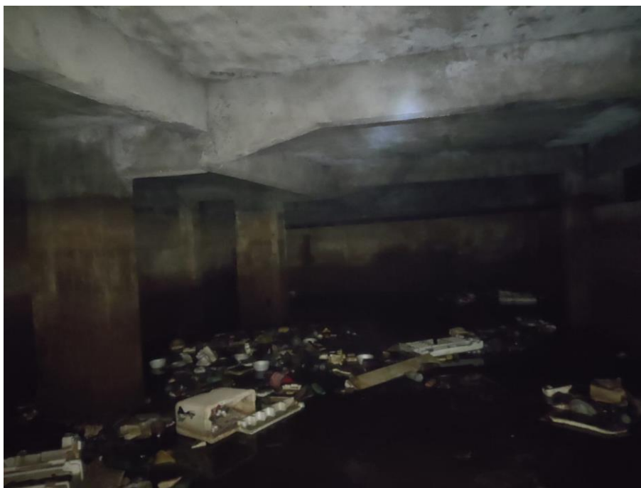
Foto 27 – Boa condição dos pilares no subsolo
