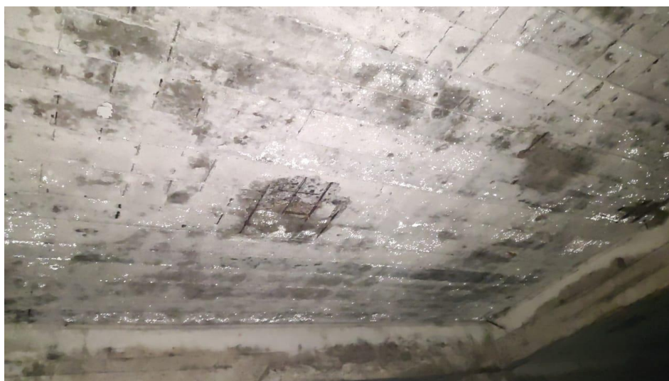
Foto 11 – Exposição de abertura no concreto de cobertura. Tipo e
