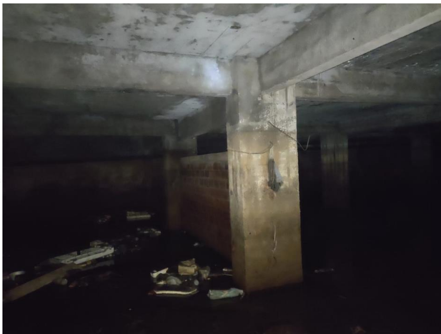
Foto 26 – Boa condição dos pilares no subsolo e parede fora do projeto
