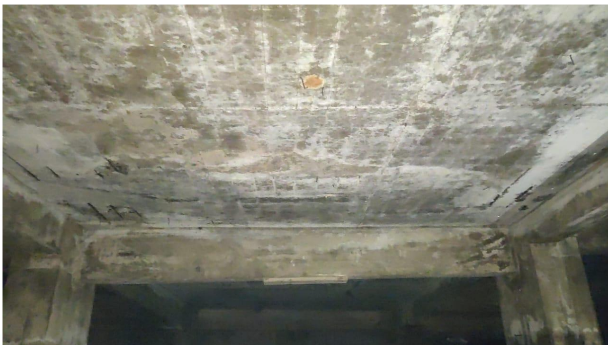
Foto 04 – Armaduras expostas em duas pequenas regiões. Tipo a.
