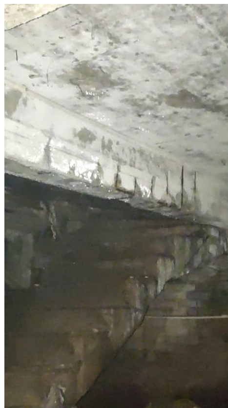
Foto 13 – Armadura de estribo em uma das faces exposta e da escada de acesso, ao lado do poço dos elevadores, desobstruída durante os exames. Tipo b
