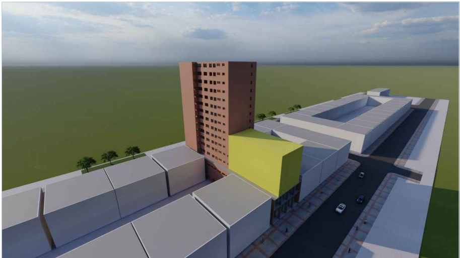
Solução mantendo os afastamentos existentes (mín. 2m) até h=14 m de face à ventilar = 4 pavimentos novos
