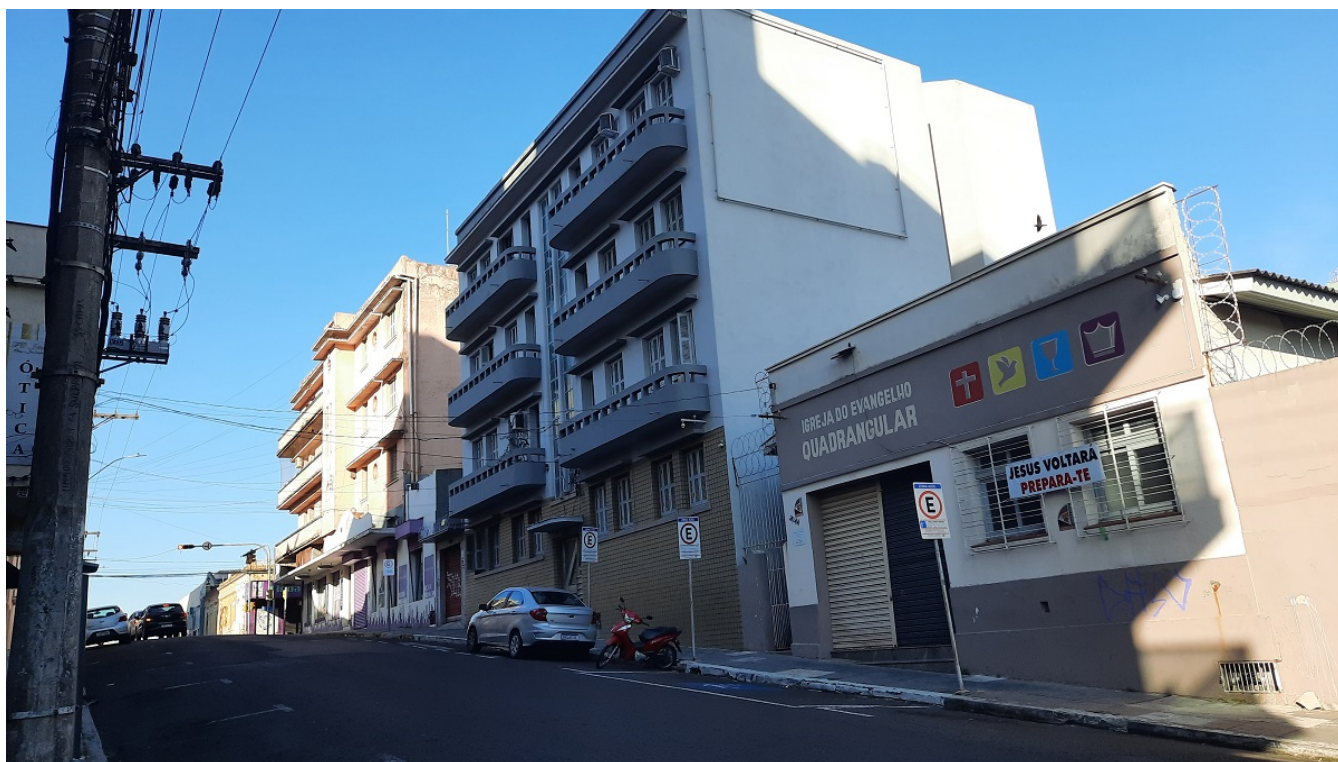
Figura 31: Vista da Rua Tuiuti, demonstrando o entorno imediato da edificação à esquerda da foto. Fonte: FAGUNDES, Renata M. (2025).
