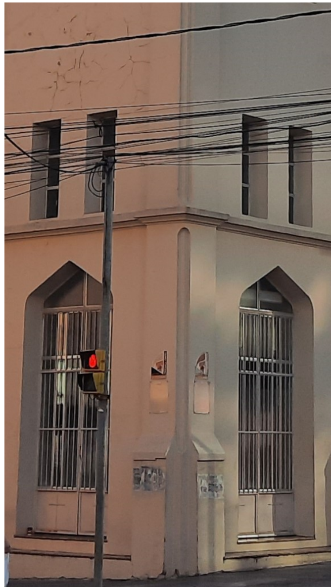
Figura 62: Pilastras e contrafortes na torre. Fonte: FAGUNDES, Renata M. (2025).
