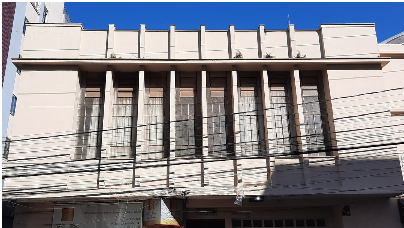
Figura 67: Brises na fachada e ameias na platibanda. Fonte: FAGUNDES, Renata M. (2023).
