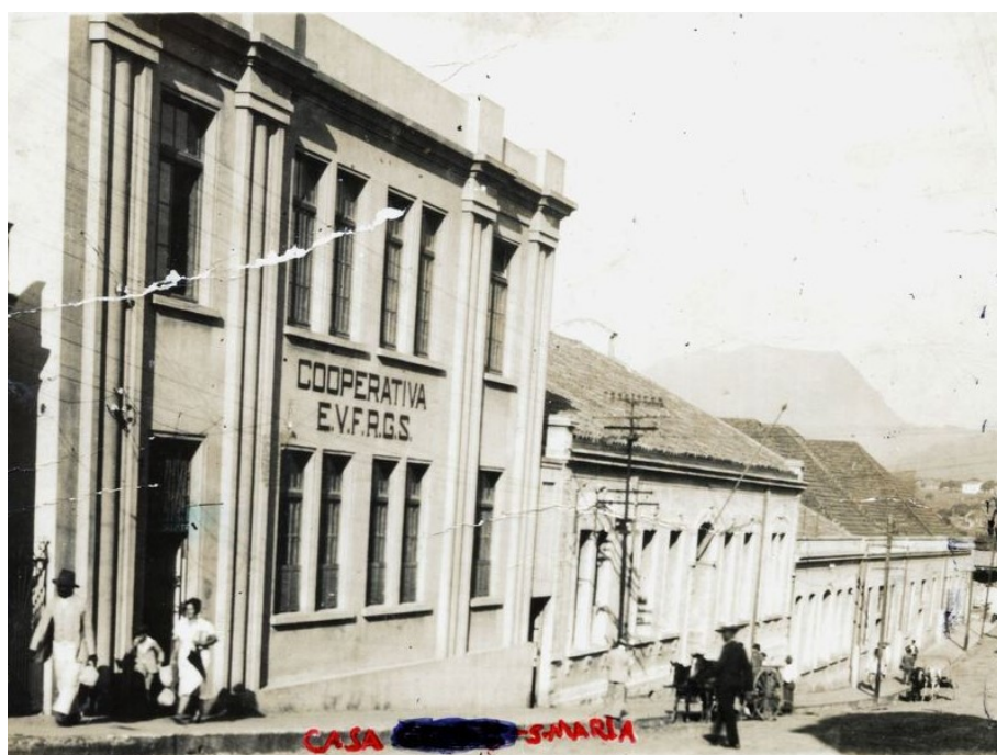
Figura 08: Cooperativa dos Empregados da Viação Férrea RS de Santa Maria em 1913. Fonte: Acervo Casa de Memória Edmundo Cardoso.
