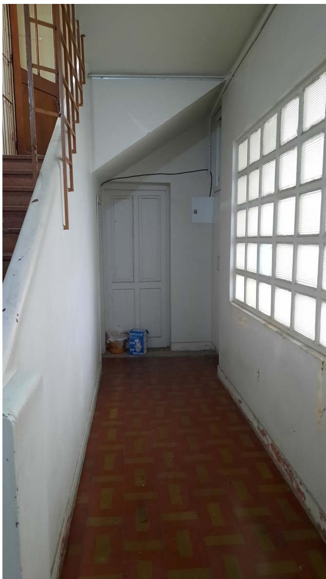
Figura 53: Hall de entrada do Edifício Educacional, com escada interna localizada no lado esquerdo da foto. Fonte: FAGUNDES, Renata M. (2023).
