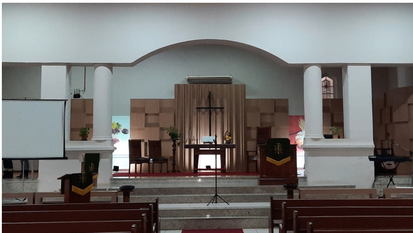
Figura 66: Pórtico com pilares de base redonda e quadrada e arco abatido. Fonte: FAGUNDES, Renata M. (2022).
