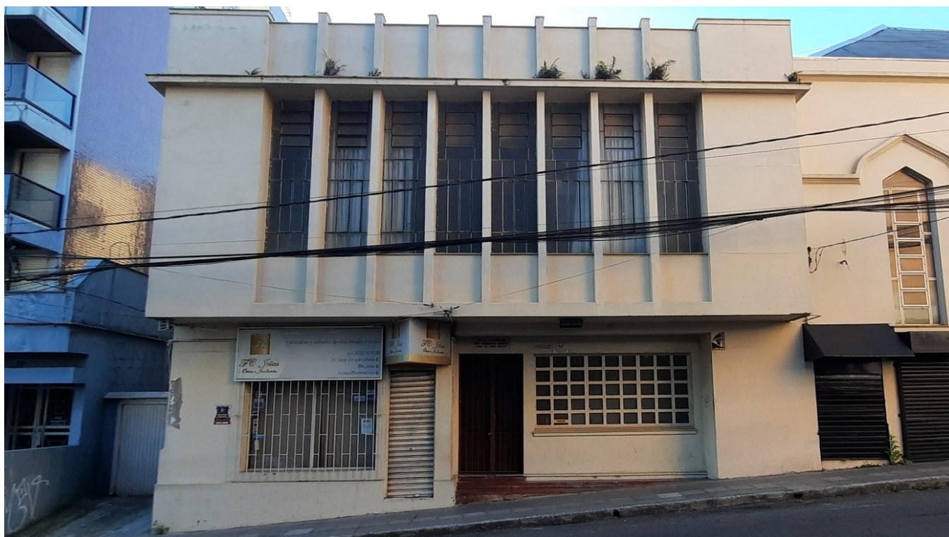
Figura 37: Fachada noroeste do Edifício Educacional (Rua Tuiuti). Fonte: FAGUNDES, Renata M. (2025).
