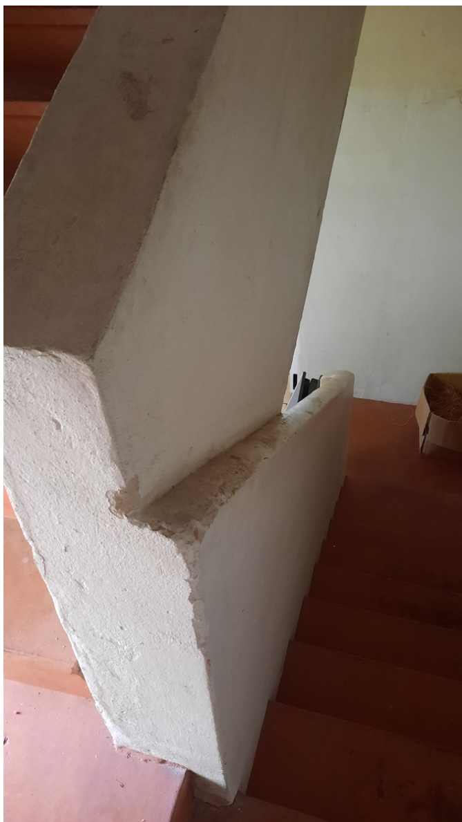
Figura 59: Escada interna de acesso ao apartamento. Fonte: FAGUNDES, Renata M. (2023).
