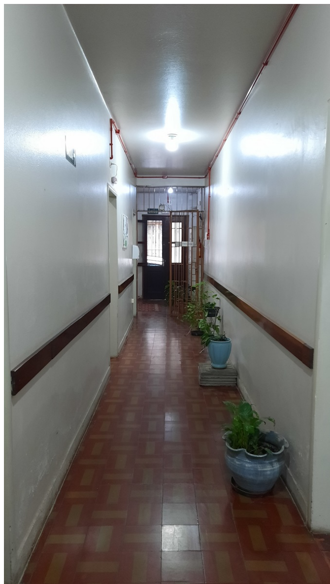
Figura 54: Vista do corredor do Edifício Educacional em direção ao hall de entrada. Fonte: FAGUNDES, Renata M. (2023).
