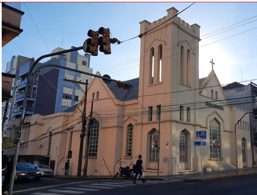
Figura 02: Fachadas Noroeste e Sudoeste da Igreja Metodista Central de Santa Maria. Fonte: FAGUNDES, Renata M. (2025).
