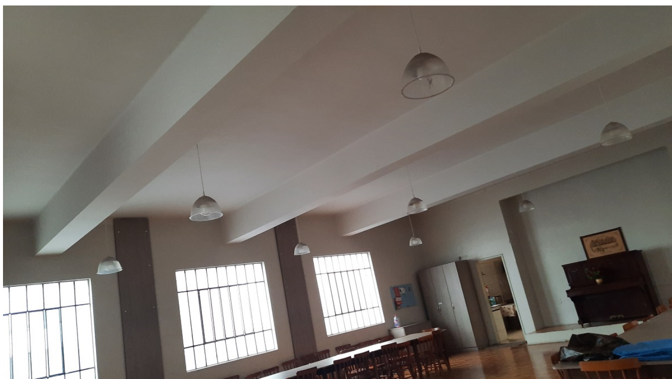
Figura 68: Vigas Salão Social. Fonte: FAGUNDES, Renata M. (2024).
