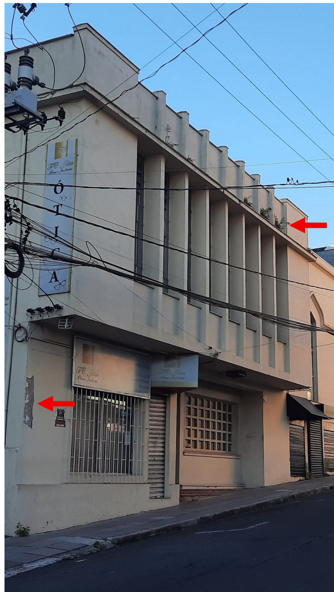
Figuras 69 e 70: Presença de vegetação e descascamento de pintura nas fachadas. Fonte: FAGUNDES, Renata M. (2025).
