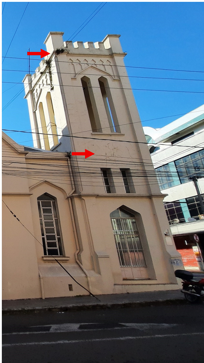
Figuras 69 e 70: Presença de vegetação e descascamento de pintura nas fachadas. Fonte: FAGUNDES, Renata M. (2025).
