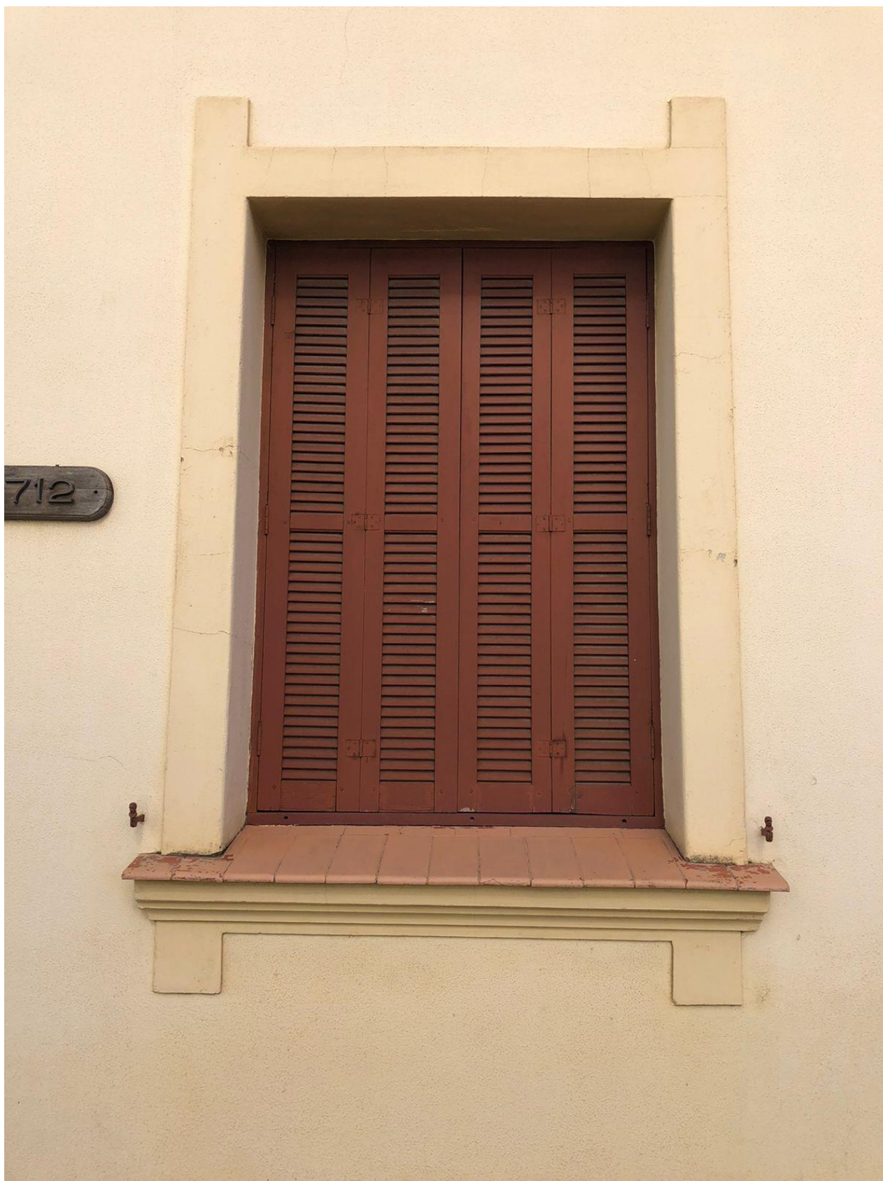
Figura 40: Esquadrias, retas, com arremates retilíneos, em relevo, rua Pinheiro Machado, 2712, Casa de Memória Edmundo Cardoso
