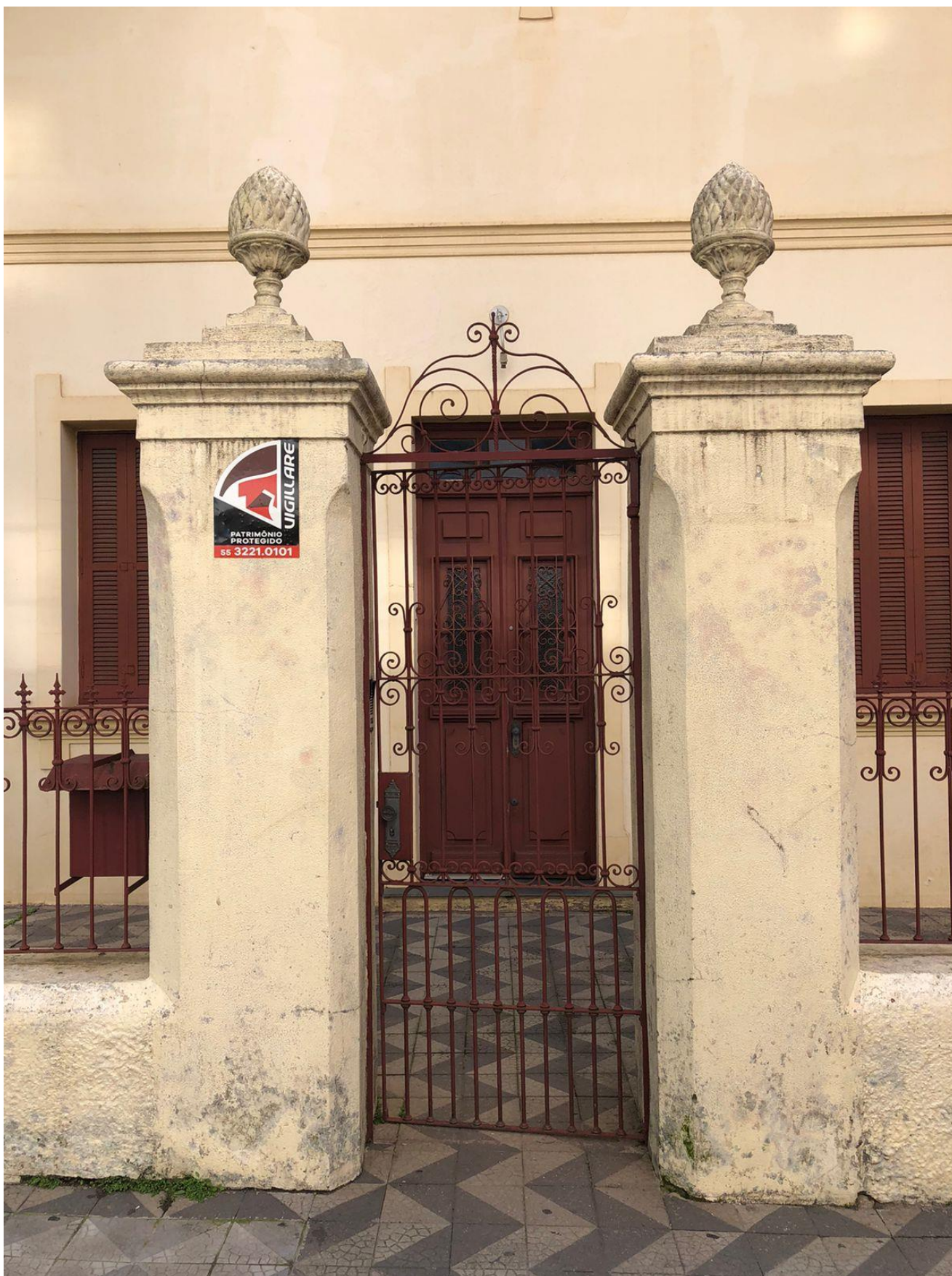
Figura 39: Gradis de ferro forjado, estilo Neoclássico, rua Pinheiro Machado, 2712, Casa de Memória Edmundo Cardoso
