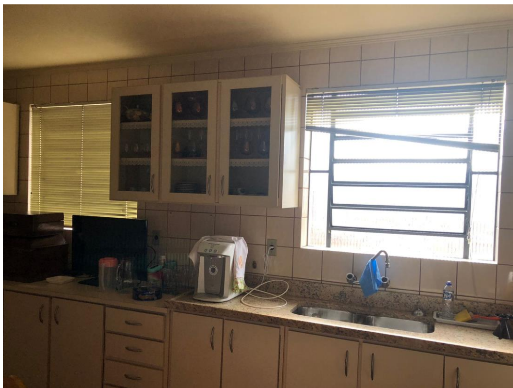
Figura 132: Basculante de Ferro, Cozinha (Fachada Norte), 120x110m.
