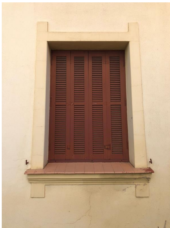
Figura 125: Janela Suíte 1 (Fachada Sul), 110x180cm.
