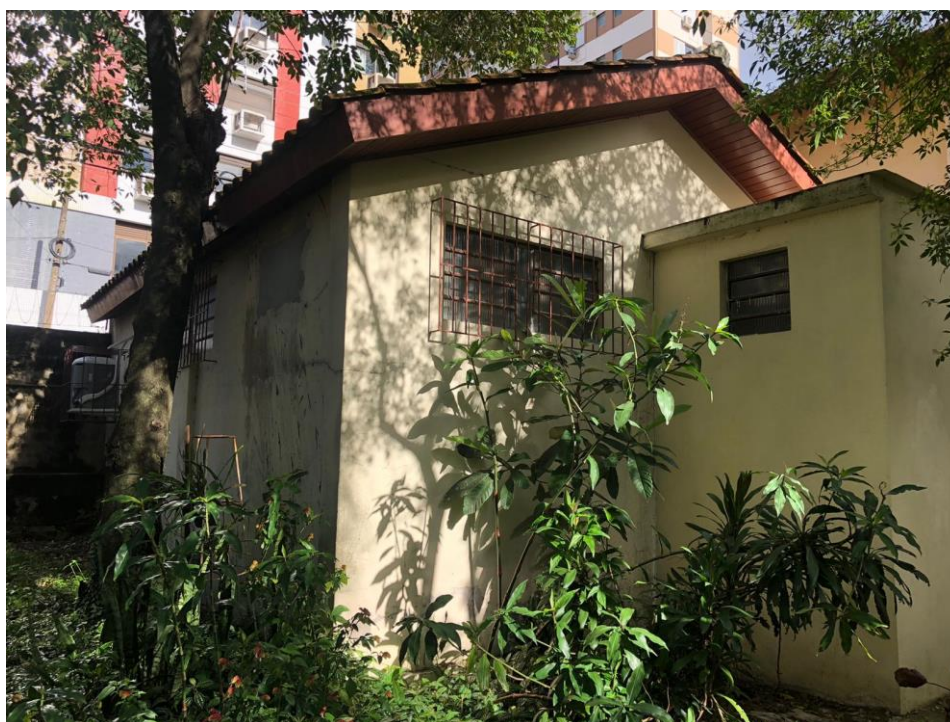
Figura 139: Basculantes de Ferro, antiga Garagem (atual Auditório Claudio Cardoso) e sanitário, (Fachadas Leste e Norte), 120x140m e 55x55m.
