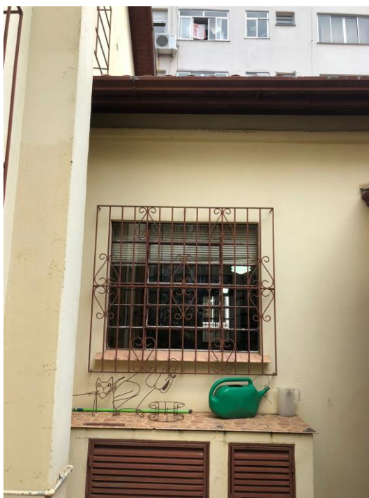
Figura 131: Basculante de Ferro Sala de Jantar (Fachada Leste), 140x120m.
