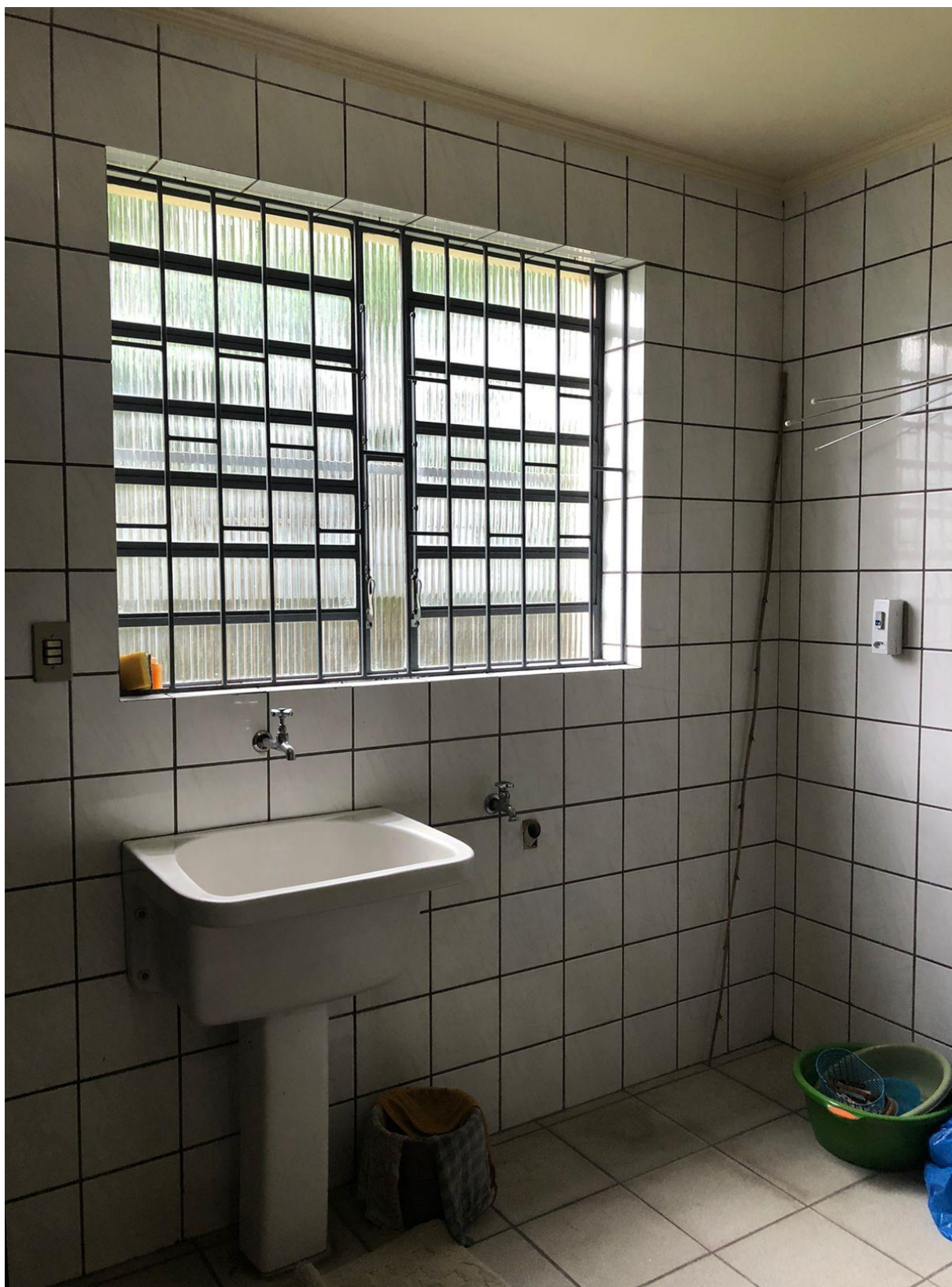
Figura 142: Basculante de Ferro, Lavanderia, Subsolo, 140x110m.
