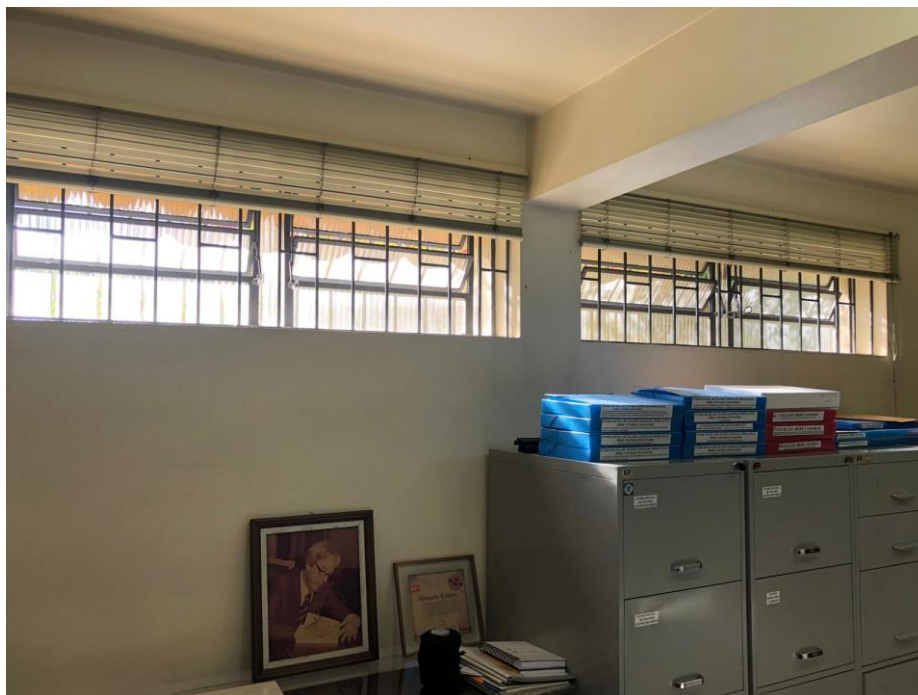
Figura 140: Basculantes de Ferro, Arquivo, Subsolo, 180x50m.
