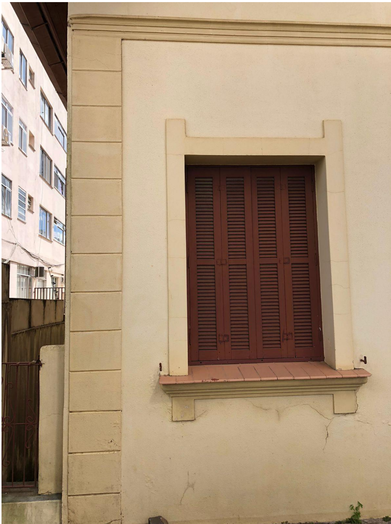
Figura 44: Detalhamento dos ornamentos: cimalha, frisos e molduras
