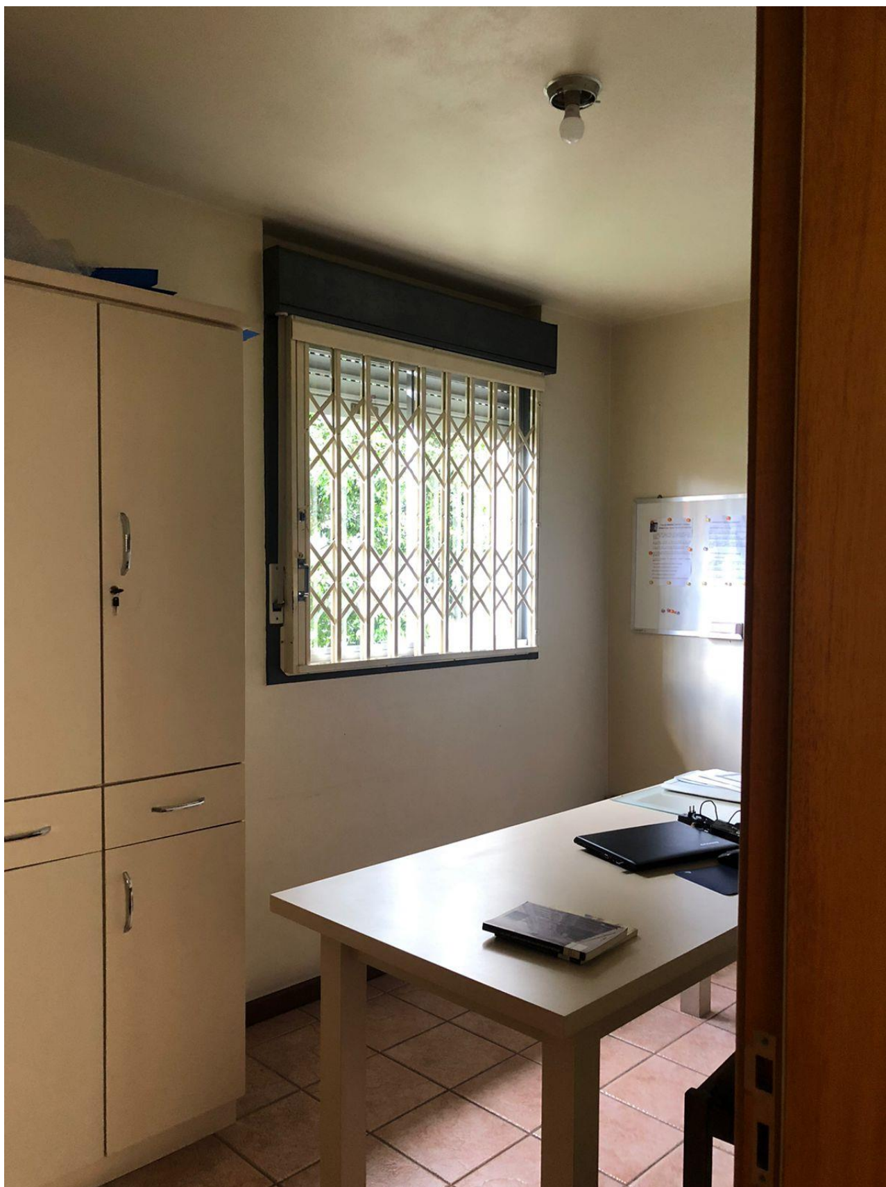
Figura 135: Janela de Ferro com persiana vertical, Sala de Pesquisa, 140x120m.
