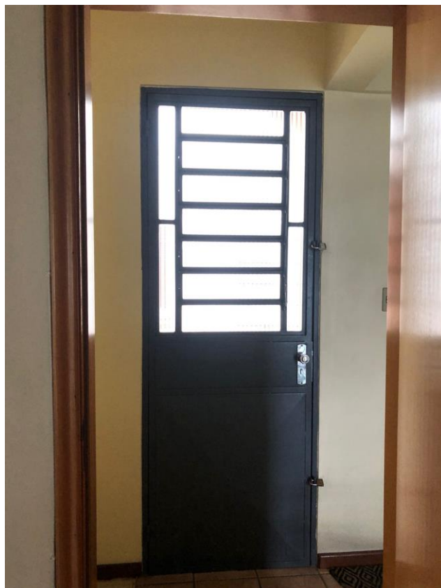
Figura 116: Porta acesso ao pátio pavimento térreo, 80x210m.
