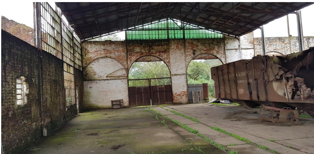
Figura 37 - Detalhe interno da estrutura da cobertura restante e dos arcos plenos da fachada 01 - Fonte: Silvio Fogaça (2018)
