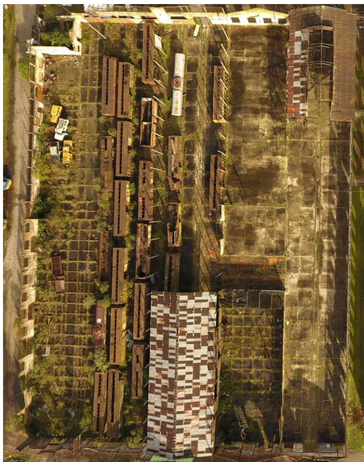
Figura 46 - Coberturas existentes na edificação - Fonte: UP3D Imagens (2018)
