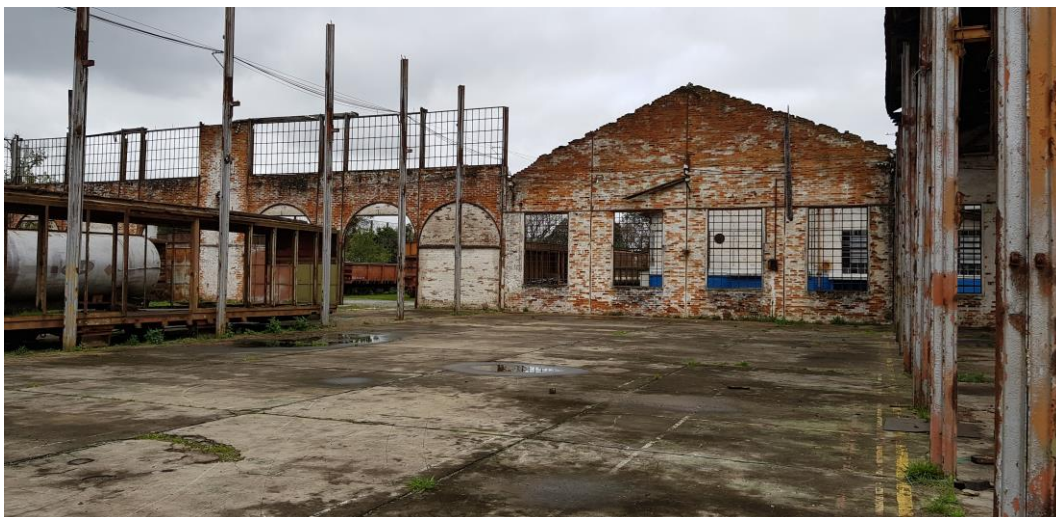
Figura 31 – Vista interna da antiga área de reparação de carros - Fonte: Silvio Fogaça (2018)
