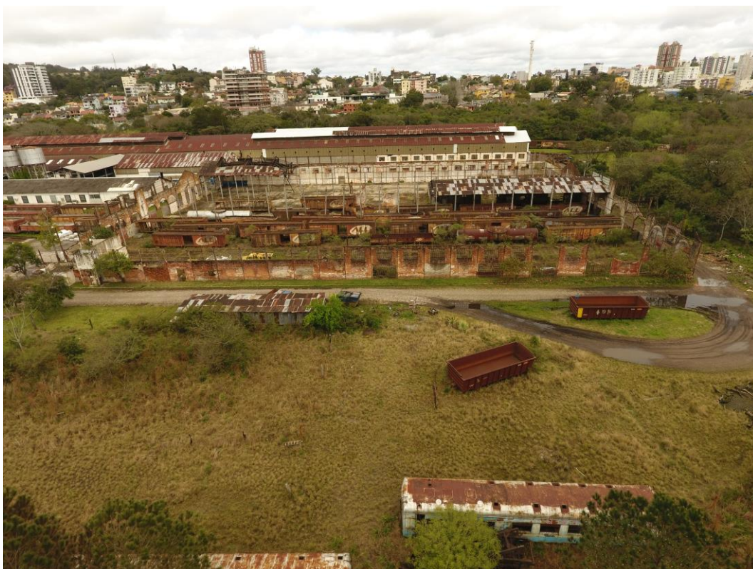
Figura 18 - Vista aérea do entorno da Antiga Oficina de Carros de Passageiros com a presença dos vagões tombados na parte inferior da imagem - Fonte: UP3D Imagens (2018)
