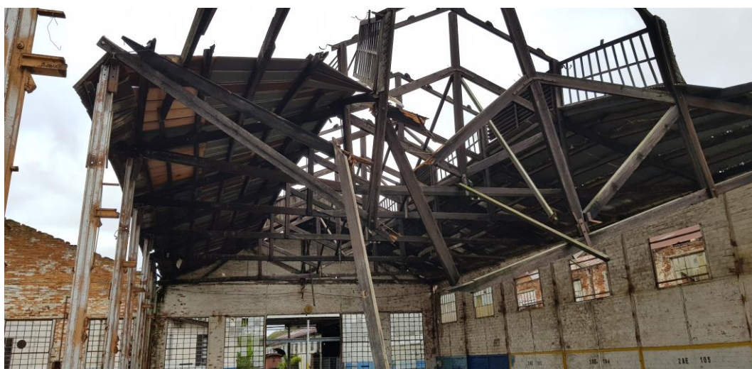
Figura 48 - Detalhe interno das treliças restantes e cobertura - Fonte: UP3D Imagens (2018)
