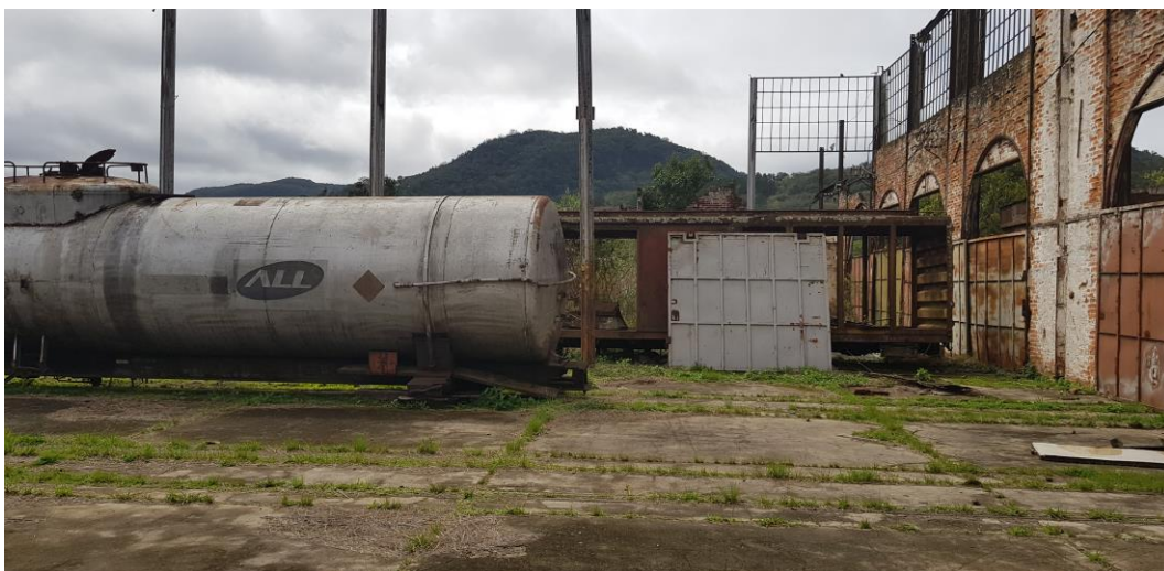
Figura 32 – Vista interna da antiga área de reparação de carros - Fonte: Silvio Fogaça (2018)
