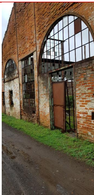
Figura 34 – Detalhe externo do arco pleno do portão de acesso - Fonte: Silvio Fogaça (2018)
