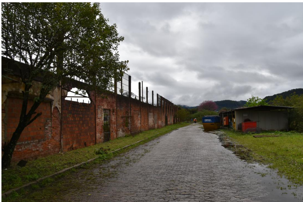
Figura 22 - Vista externa da elevação 04 - Fachada Nordeste - Fonte: UP3D Imagens (2018)
