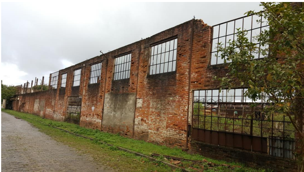
Figura 19 - Vista externa da elevação 04 - Fachada Nordeste - Fonte: Silvio Fogaça (2018)
