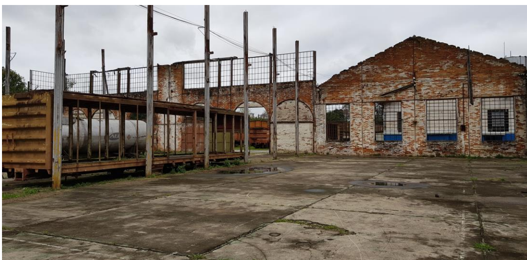
Figura 40 - Detalhe interno da estrutura em perfis de trilho de trem remanescentes - Fonte: Silvio Fogaça (2018)
