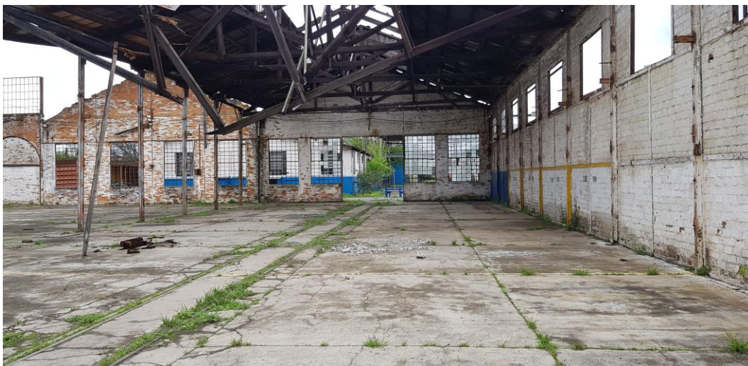
Figura 41 - Detalhe interno da pavimentação em concreto e dos trilhos para acesso dos carros - Fonte: Silvio Fogaça (2018)
