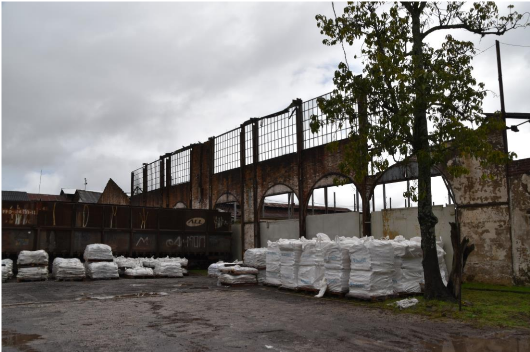
Figura 23 - Vista interna da elevação 02 - Fachada Sudoeste - Fonte: Silvio Fogaça (2018)
