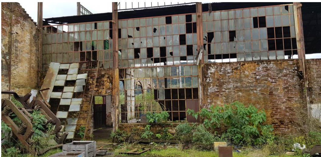
Figura 45 - Detalhe externo das esquadrias metálicas com painéis de vidro - Fonte: Silvio Fogaça (2018)
