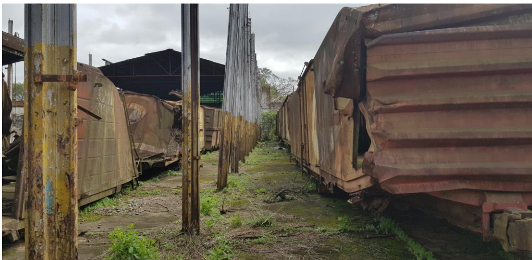
Figura 43 - Detalhe da estrutura em perfis metálicos de trilhos de trem para apoio das treliças da cobertura - Fonte: Silvio Fogaça (2018)
