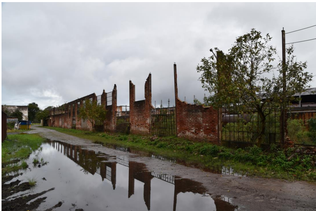
Figura 21 - Vista externa da elevação 04 - Fachada Nordeste - Fonte: UP3D Imagens (2018)
