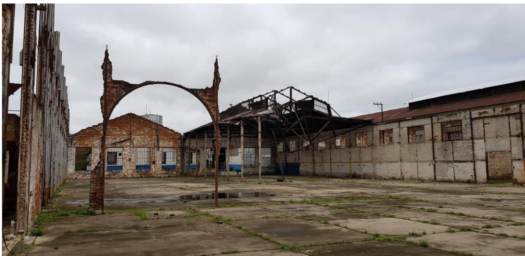
Figura 39 - Detalhe interno da estrutura do arco pleno - Fonte: Silvio Fogaça (2018)
