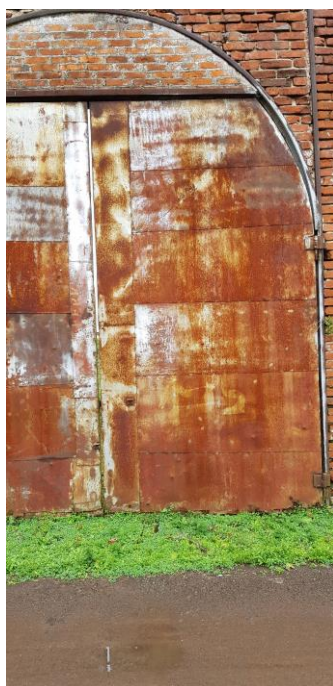
Figura 36 - Detalhe externo das portas de acesso - Fonte: Silvio Fogaça (2018)
