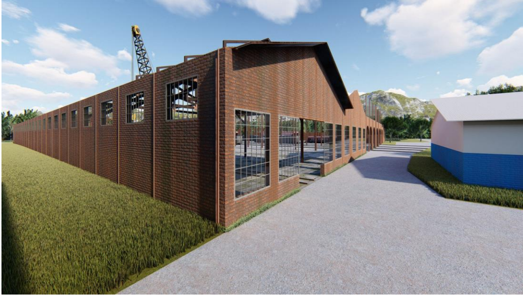
Figura 11 - Imagem ilustrativa das ruínas do edifício da Antiga Oficina de Carros de Passageiros – Fonte: Varínia Schwartz Arquitetura (2018)
