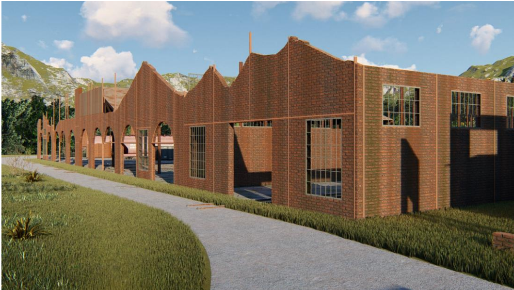
Figura 5- Imagem ilustrativa das fachadas 01 e 02 das ruínas do edifício da Antiga Oficina de Carros de Passageiros - Fonte: Varínia Schwartz Arquitetura (2018)
