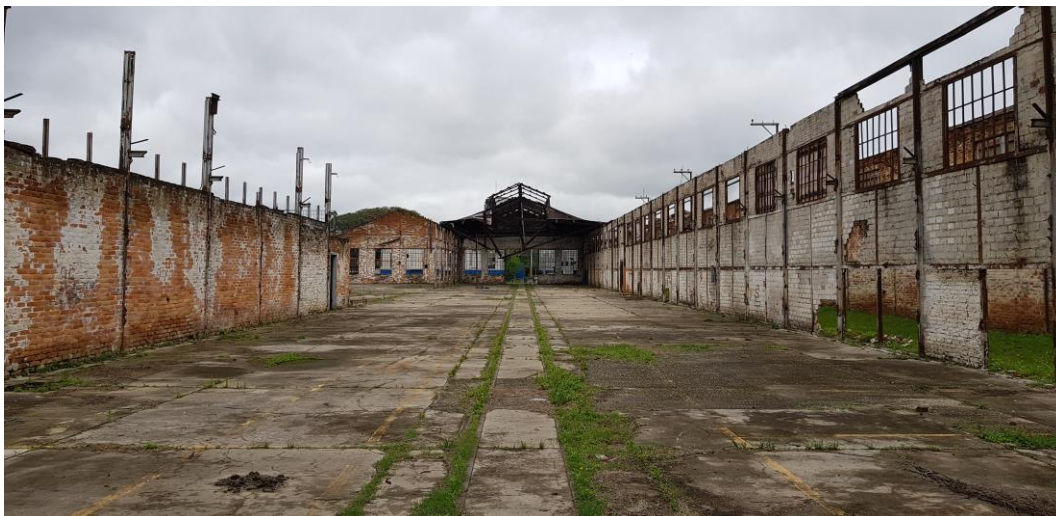
Figura 25 – Vista interna em direção a elevação 02 - Fonte: Silvio Fogaça (2018)
