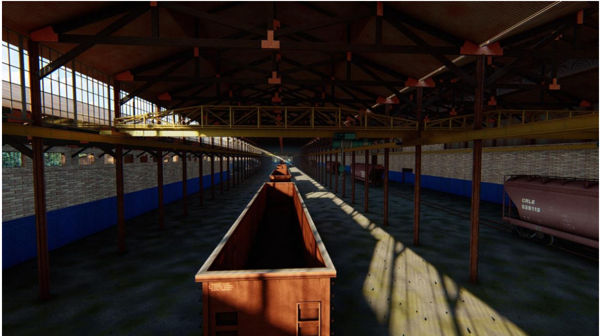
Figura 10 - Imagem ilustrativa do interior do edifício da Antiga Oficina de Vagões - Fonte: Varínia Schwartz Arquitetura (2018)
