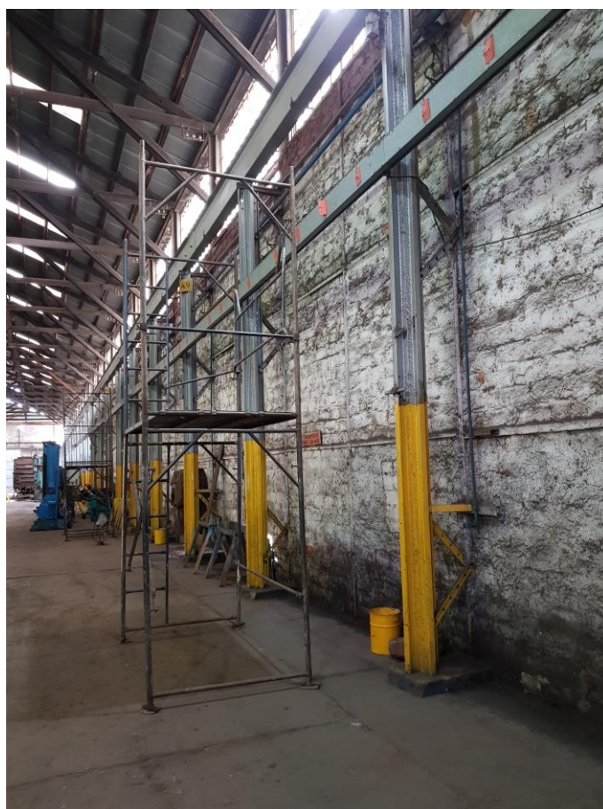
Figura 35 - Detalhe interno da estrutura da ponte rolante - Fonte: Silvio Fogaça (2018)
