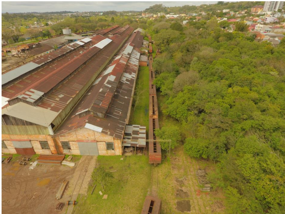
Figura 48 - Detalhe externo dos lanternins - Fonte: UP3D Imagens (2018)
