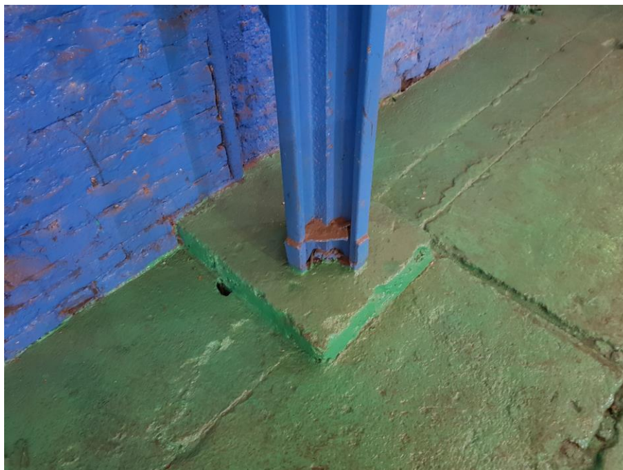
Figura 33 - Sapata de apoio dos pilares de sustentação da ponte rolante - Fonte: Silvio Fogaça (2018)
