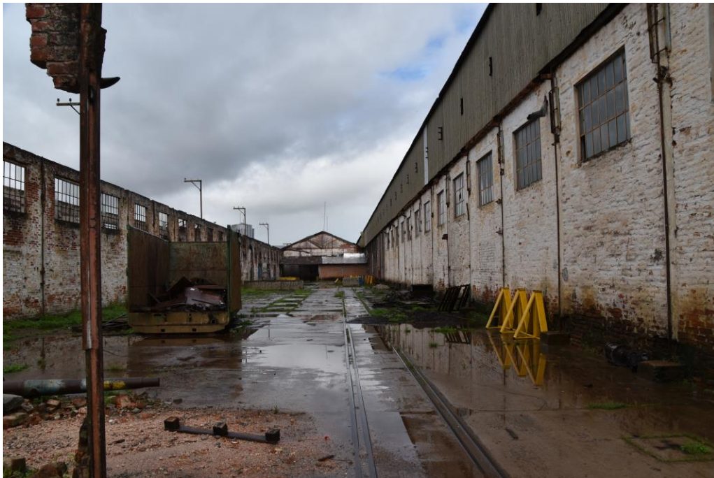
Figura 49 - Vista interna das ruínas da ferramentaria da oficina de vagões - Fonte: UP3D Imagens (2018)
