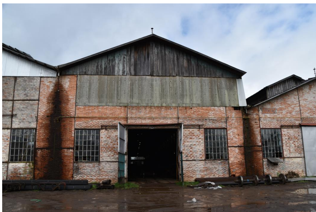
Figura 56 - Detalhe externo do portão de acesso, fechamento em telha metálica e fechamento do oitão em madeira sistema mata-junta - Fonte: UP3D imagens - (2018)
