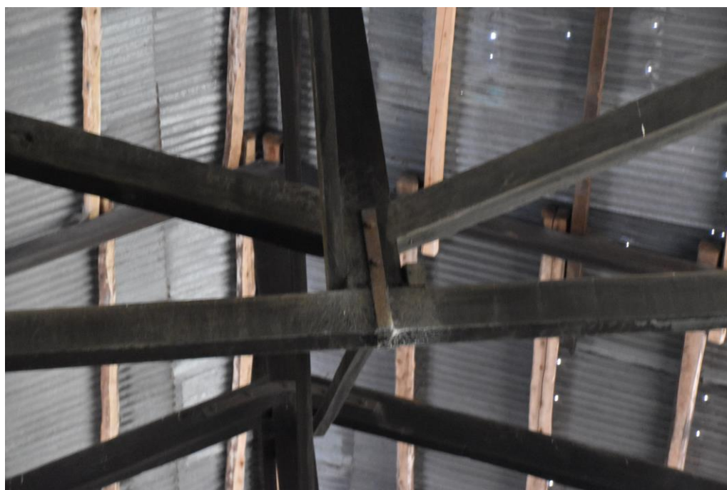
Figura 37 - Detalhe interno da treliça de cobertura - Encaixes - Fonte: UP3D Imagens (2018)
