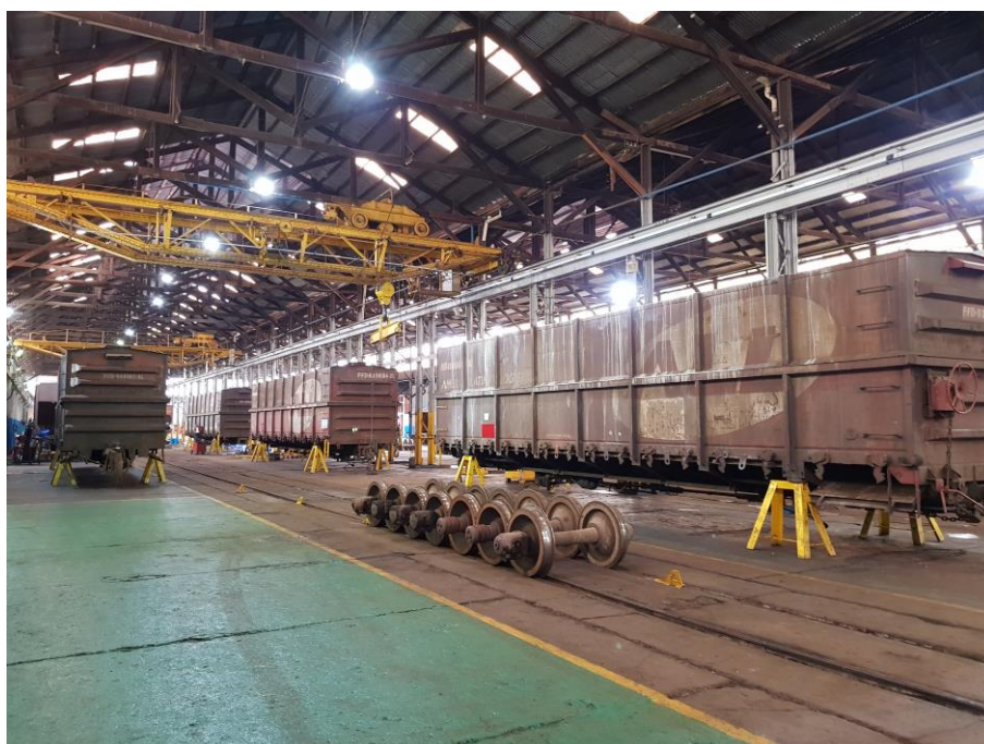
Figura 25 - Vista interna da área de reparo de vagões - Fonte: Silvio Fogaça (2018)
