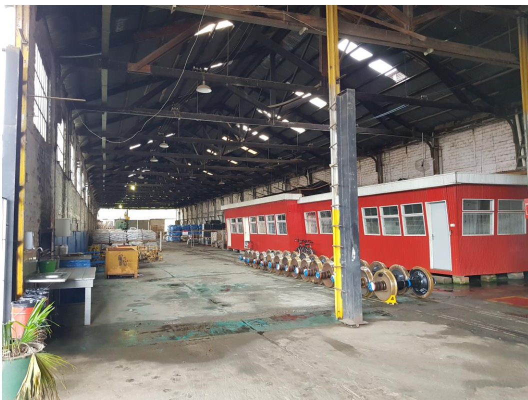
Figura 24 - Vista interna do Almoxarifado - Fonte: Silvio Fogaça (2018)
