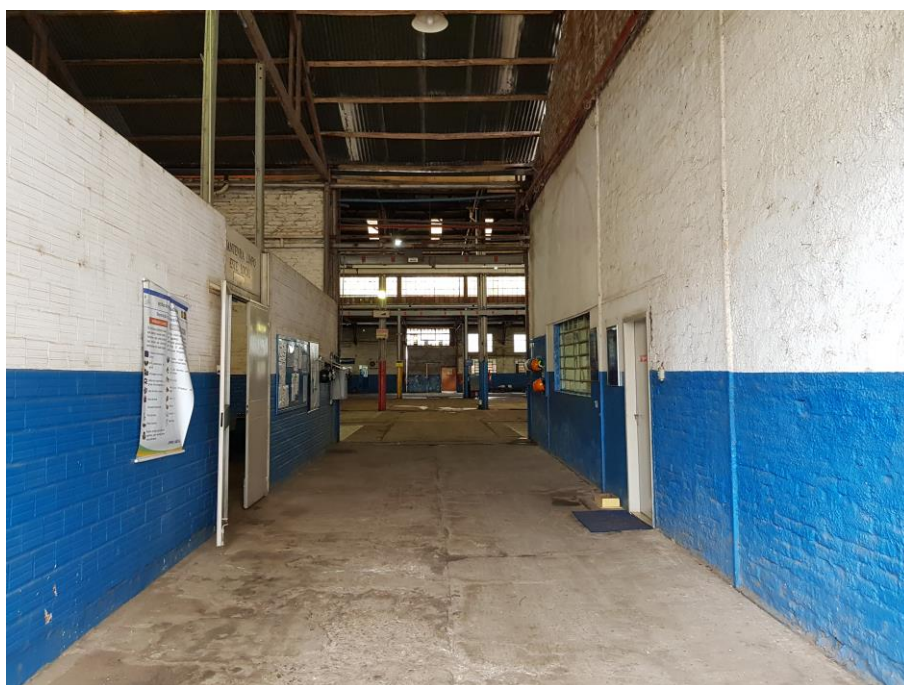
Figura 44 - Detalhe interno do corredor de acesso - Paredes de alvenaria pintadas em azul e branco - Fonte: Silvio Fogaça (2018)
