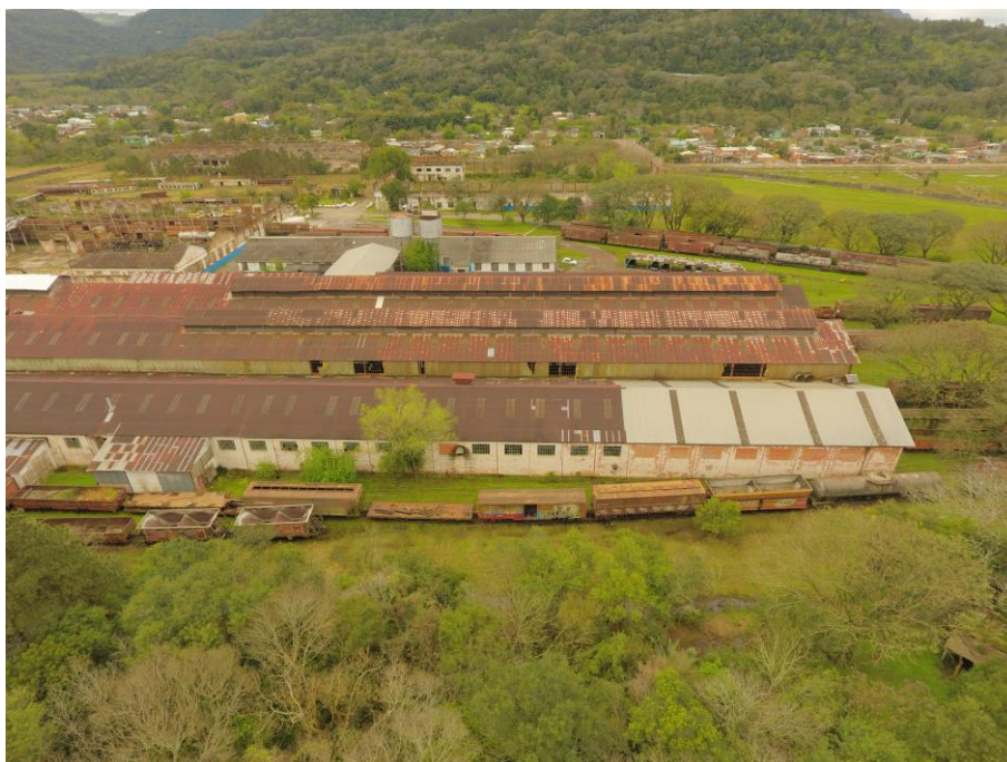
Figura 71 - Vários apêndices ao edifício foram construídos com o passar do tempo - inúmeros vãos das esquadrias foram fechados para adequações do uso dos espaços - Fonte: UP3D Imagens (2018)
