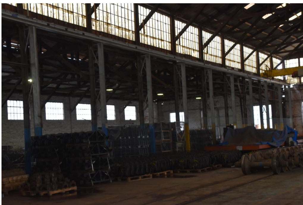
Figura 39 - Detalhe interno dos painéis de esquadrias - Fonte: UP3D Imagens (2018)
