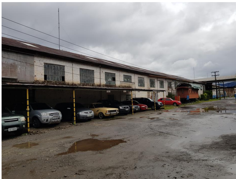
Figura 18 - Vista externa da elevação 08 - Fachada Nordeste - Fonte: Silvio Fogaça (2018)
