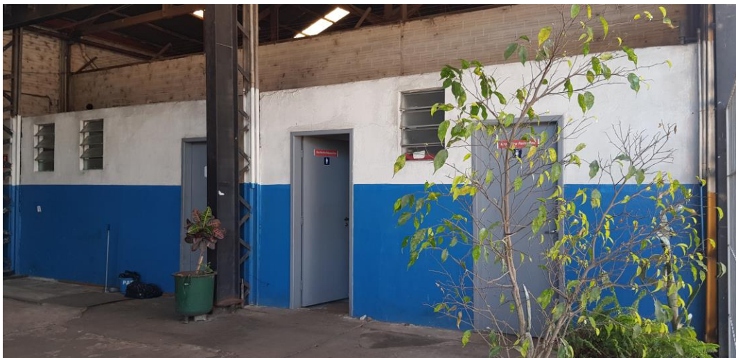
Figura 31 - Vista interna da área dos banheiros - Fonte: Silvio Fogaça (2018)
