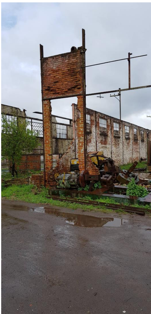
Figura 60 - Área da Antiga Ferramenta da Oficina de Vagões completamente em ruínas - Fonte: Silvio Fogaça (2018)
