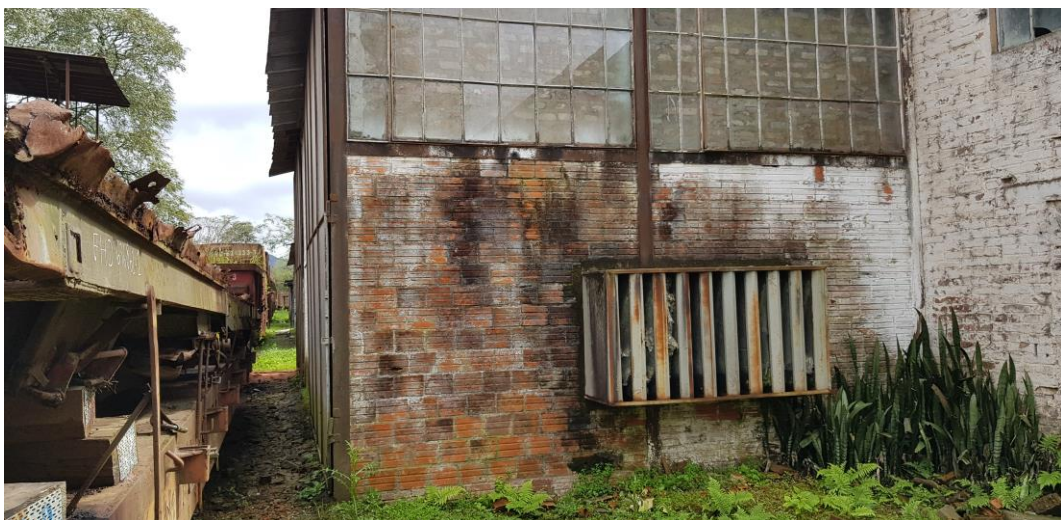
Figura 50 - Apêndices construídos junto a oficina de recuperação de vagões - Fonte: Silvio Fogaça (2018)
