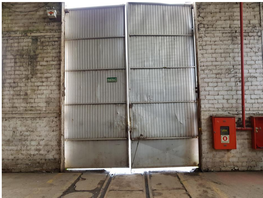
Figura 34 - Detalhe interno das portas de acesso, observar trilho para entrada e circulação dos vagões- Fonte: Silvio Fogaça (2018)
