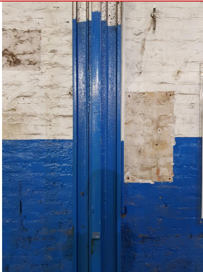
Figura 32 - Pilares de sustentação da ponte rolante - Fonte: Silvio Fogaça (2018)
