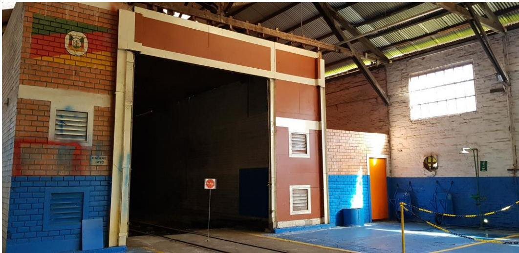
Figura 28 - Vista interna da Cabina de Jateamento - Fonte: Silvio Fogaça (2018)
