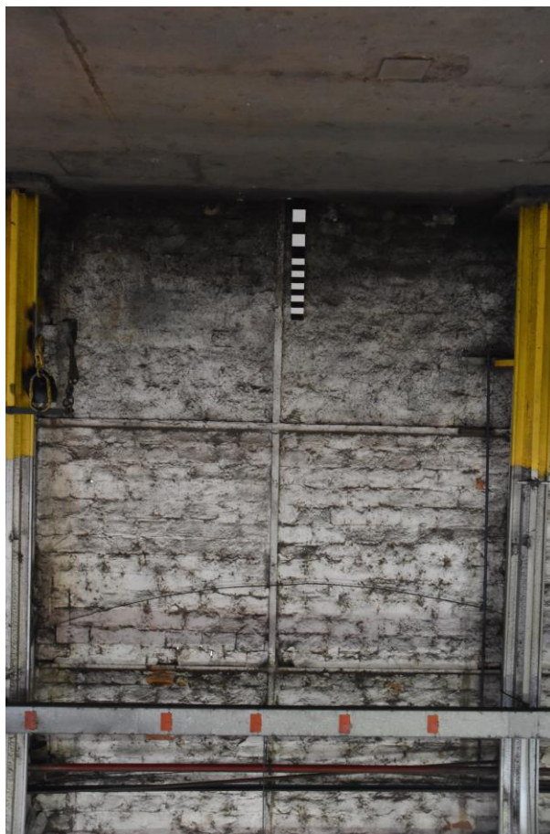
Figura 36 - Detalhe interno da estrutura dos quadros em trilho formando as paredes de vedação - Fonte: UP3D Imagens (2018)
