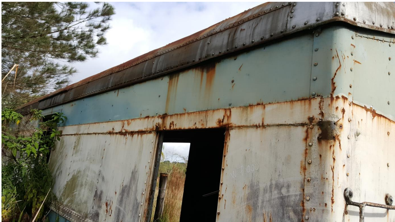
Figura 11 – Detalhe Chapas Rebitadas - Fonte: Varinia Schwartz
