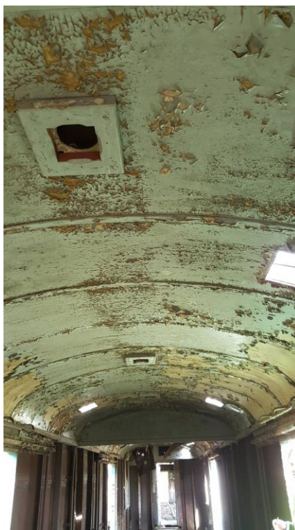
Figura 12 - Detalhe Forro Metalico - Fonte: Varinia Schwartz
