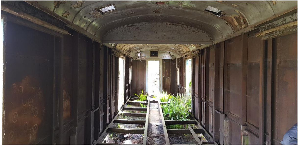
Figura 17 - Esquadrias inexistentes - piso inexistente - Fonte: Silvio Fogaça
