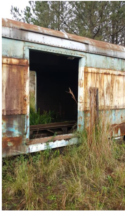
Figura 13 – Detalhe Porta de Acesso - Fonte: Varinia Schwartz
