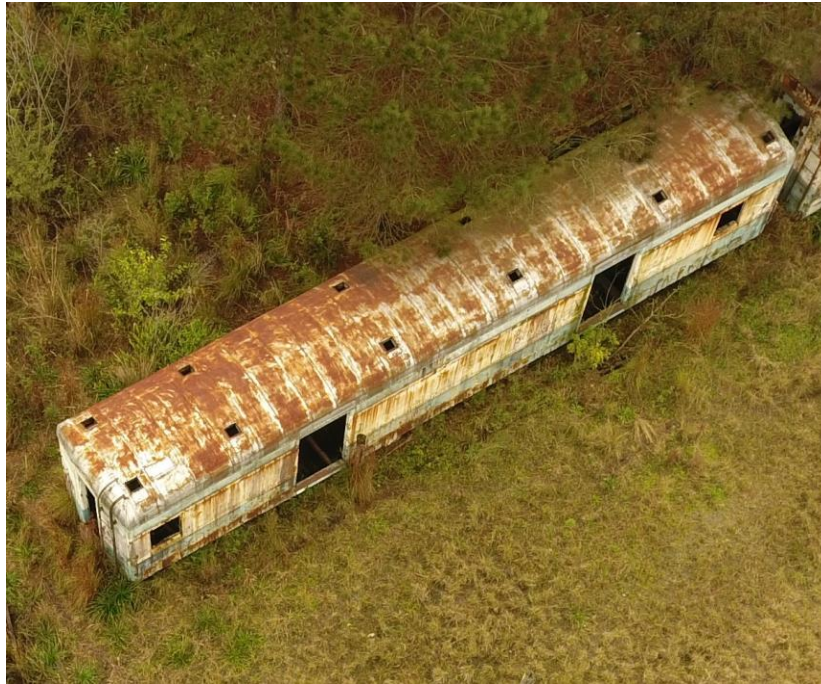
Figura 15 – Vagão com oxidação da lataria - Fonte: UP3D Imagens
