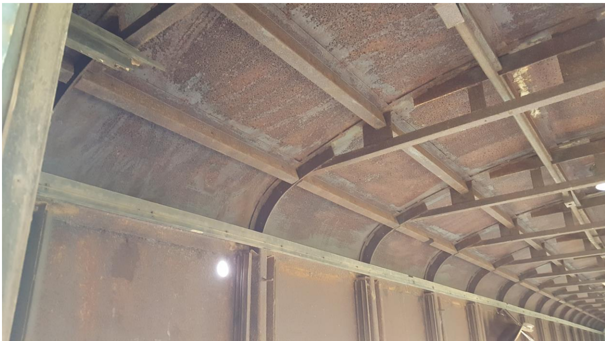
Figura 14 – Detalhe estrutura - Vagão Passageiros QC8399-4N - Fonte: Varinia Schwartz
