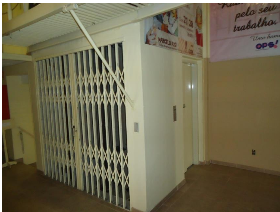
Figura 26: Vista do elevador hidráulico no pavimento térreo do Theatro Treze de Maio. Fonte: PEREYRON, D.(2010)
