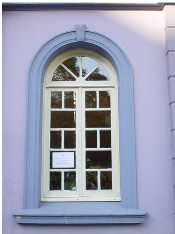
Figura 30: Detalhe da esquadria externa com verga em arco pleno. Fonte: PEREYRON, R.(2010).
