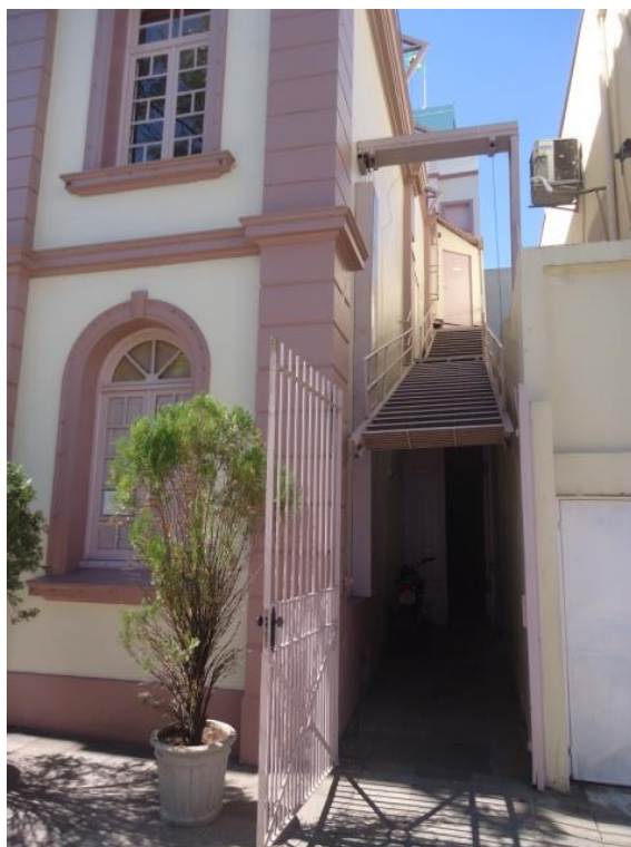
Figura 06: Detalhe da escada retrátil do Theatro Treze de Maio. Fonte: PEREYRON, D.(2010)
