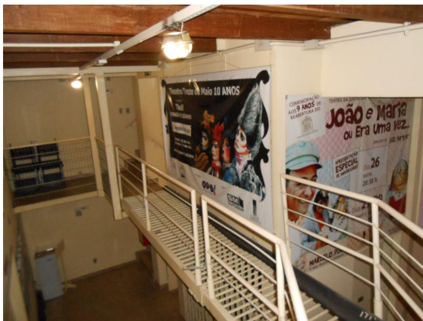
Figura 35: Detalhe da passarela metálica instalada para manutenção na cabine técnica. Fonte: KESSLER, F.(2013).
