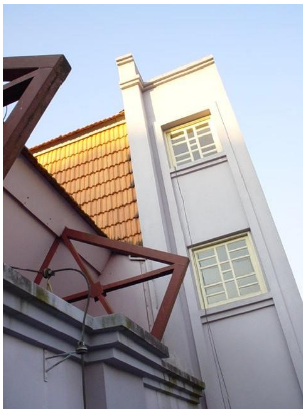
Figura 33: Detalhe do encontro da estrutura metálica com a platibanda. Fonte: KESSLER, F.(2013).
