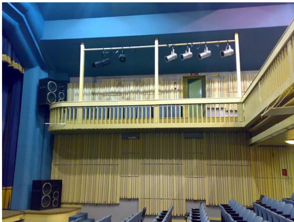
Figura 27: Vista dos camarotes do Theatro Treze de Maio com o detalhe do guarda-corpo em madeira e as placas em madeira também funcionando como isolamento acústico. Fonte: PEREYRON, D.(2010)
