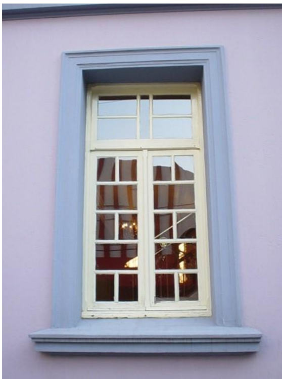
Figura 31: Detalhe da esquadria externa com verga reta. Fonte: PEREYRON, R.(2010).
