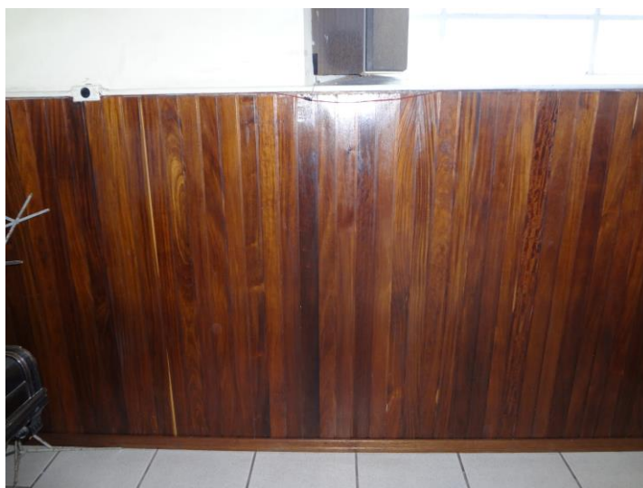
Figura 44: Lambris em madeira revestindo as paredes internas na nave da Igreja. Fonte: arquivo pessoal Janice Peiter (2015)
