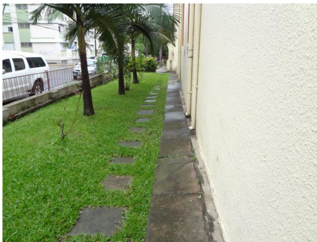
Figura 02: Circulação lateral externa a Igreja, Fachada Sudeste, Rua Cel. Niederauer. Fonte: arquivo pessoal Janice Peiter (2015)
