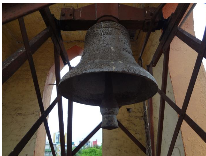
Figura 25: Sinos em estrutura metálica e madeira. Fonte: arquivo pessoal Janice Peiter (2015)
