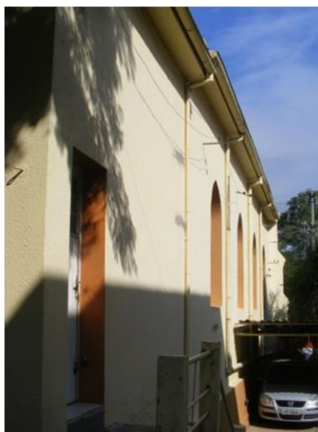
Figura 14: Fachada Noroeste, lateral da Igreja. Fonte: arquivo pessoal Janice Peiter (2015)
