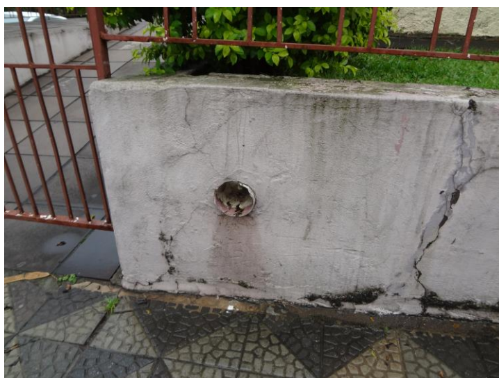
Figura 05: Escoamento pluvial direto na calçada, Rua Cel. Niederauer. Fonte: arquivo pessoal Janice Peiter (2015)
