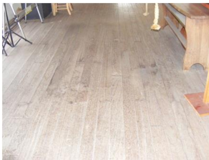
Figura 51: Piso em madeira, localizado no mezanino. Fonte: arquivo pessoal Janice Peiter (2015)
