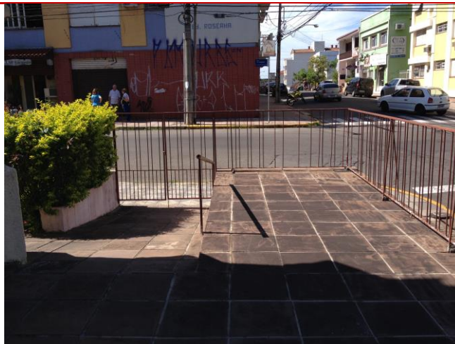
Figura 01: Rampa de acesso principal da Igreja pela Rua Cel. Niederauer. Fonte: arquivo pessoal Janice Peiter (2015)
