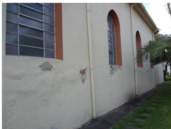
Figura 18: Conjunto de janelas basculantes, Fachada Sudeste, rua Cel. Niederauer. Fonte: arquivo pessoal Janice Peiter (2015)
