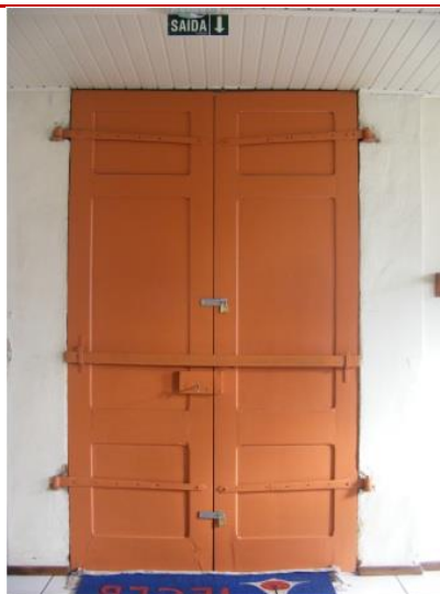
Figura 28: Porta de acesso principal, vista interna. Fonte: arquivo pessoal Janice Peiter (2015)
