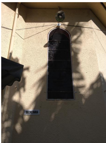
Figura 23: Vitro do altar com grade de proteção externa, fachada Leste. Fonte: arquivo pessoal Janice Peiter (2015)
