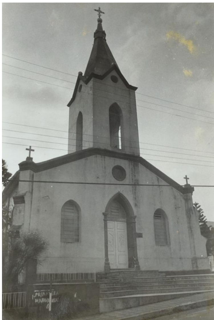
Figura 12: Fachada do Templo, sem data de registro. Fonte: Imagens da internet. (fevereiro, 2015)
