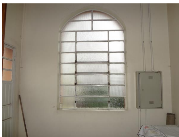
Figura 36: Janela basculante, vista interna, localizada na sacristia. Fonte: arquivo pessoal Janice Peiter (2015)
