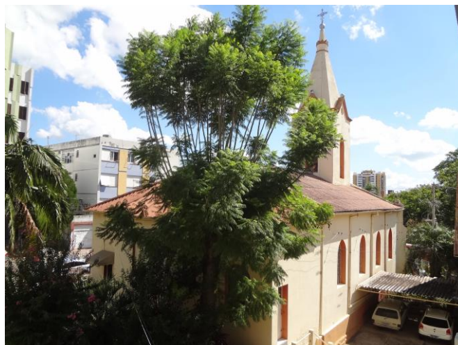
Figura 13: Fachada Noroeste, lateral da Igreja. Fonte: arquivo pessoal Janice Peiter (2015)
