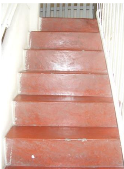
Figura 49: Escada que de acesso ao coro, segundo lance. Fonte: arquivo pessoal Janice Peiter (2015)
