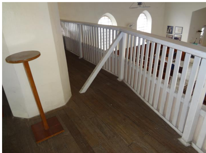
Figura 50: Guarda corpo em madeira, localizado no mezanino. Fonte: arquivo pessoal Janice Peiter (2015)
