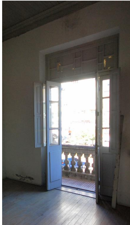
Figura 32: PSC – Porta aberta, vista internamente para a sacada. Fonte: Schneider, G.(2014)
