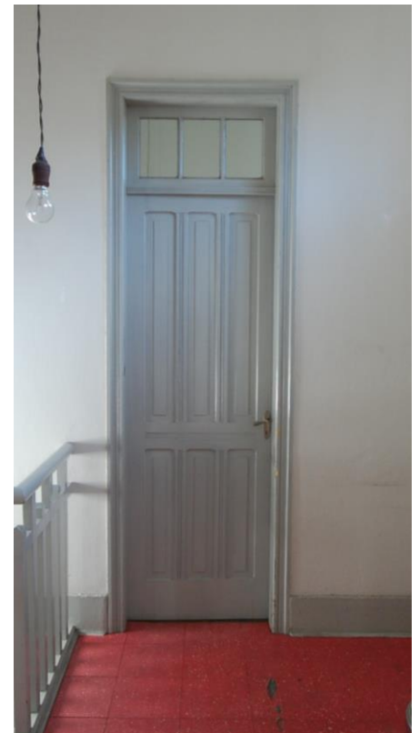
Figura 14: P05. Porta interna, pav. térreo. Fonte: Schneider. G.(2014)
