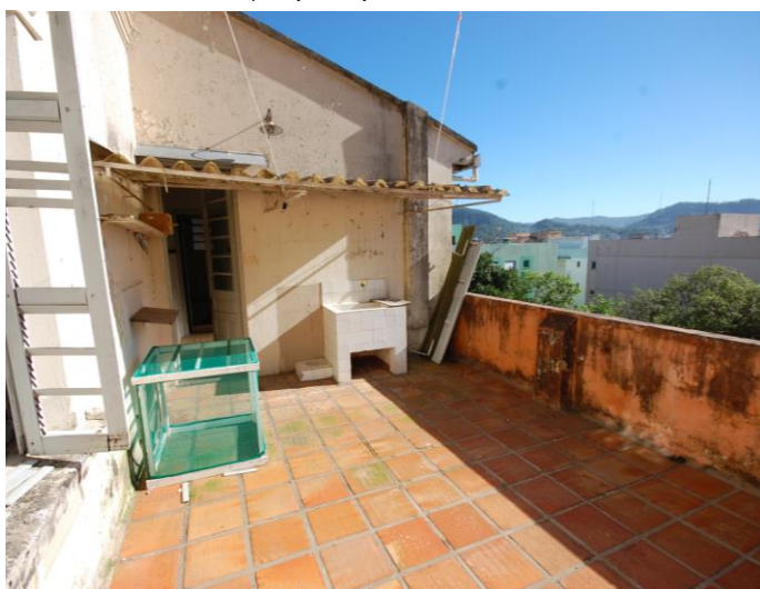
Figura 43: Terraço do segundo pavimento Fonte: Schneider, G.(2014)
