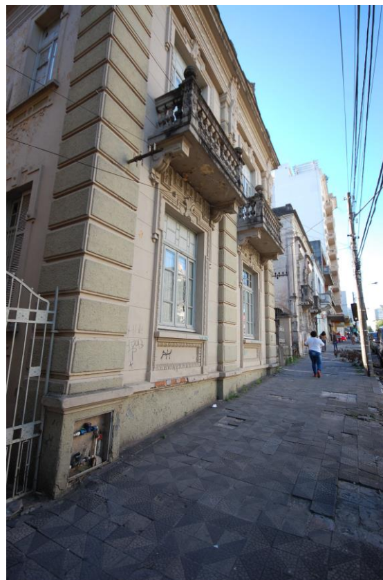
Figura 38: Fachada frontal vista pelo lado norte Fonte: Schneider. G.(2014)
