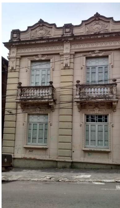
Figura 07: Fachada frontal Fonte: Schneider. G.(2014)
