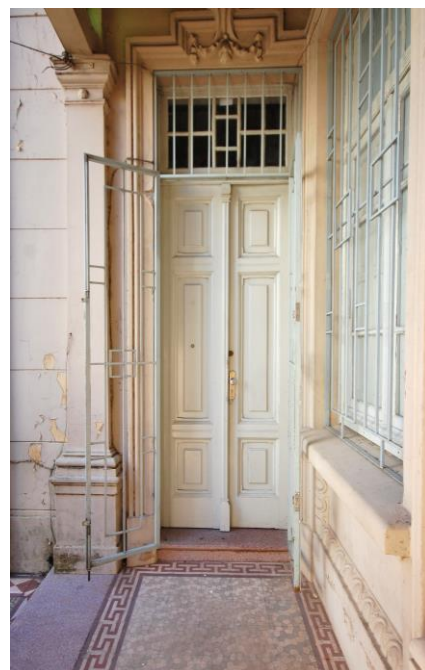
Figura 08: P01 - Porta de acesso ao térreo Fonte: Schneider, G.(2014)
