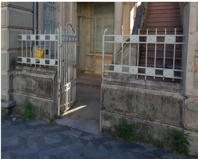
Figura 18: PG - Portão de pedestre, pav. térreo. Fonte: Schneider. G.(2014)
