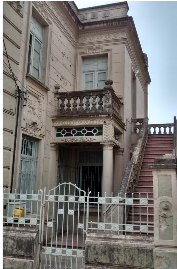
Figura 65: Detalhe do portão de acesso, com o piso em ladrilho, o vitral abaixo do balcão com balaustrada, coluna com capiteis, frisos na alvenaria e as padieiras das janelas e portas. Fonte: Bernardi. G.(2014)
