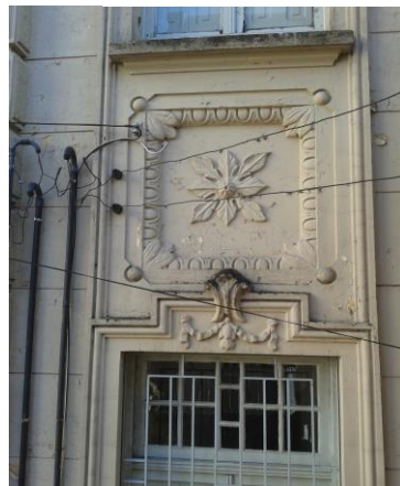
Figura 72: Canto noroeste da edificação. Fonte: Bernardi. G.(2014)
