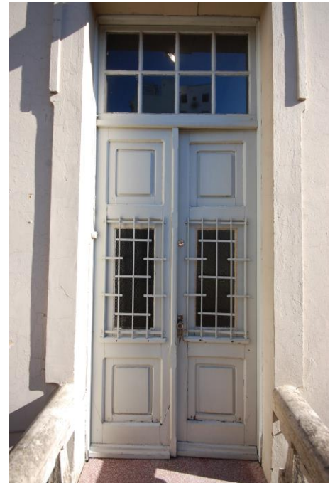
Figura 22: P11. Porta de acesso ao 2º pavimento Fonte: Schneider, G.(2014)
