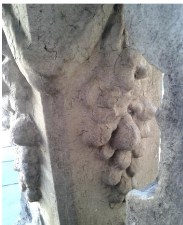
Figura 73: Detalhe do balaústre da sacada. Fonte: Bernardi. G.(2014)
