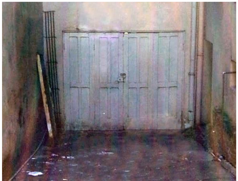
Figura 35: PG – Portão da garagem, subsolo. Fonte: Schneider, G.(2014)
