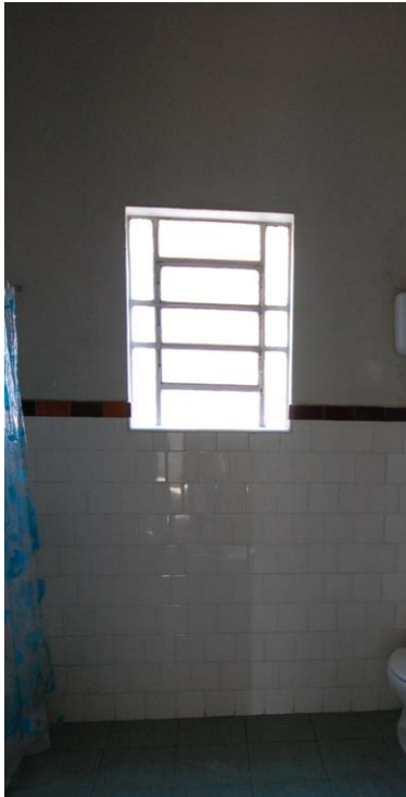
Figura 31: J05 - Janela vista internamente, 2º pavimento. Fonte: Schneider. G.(2014)
