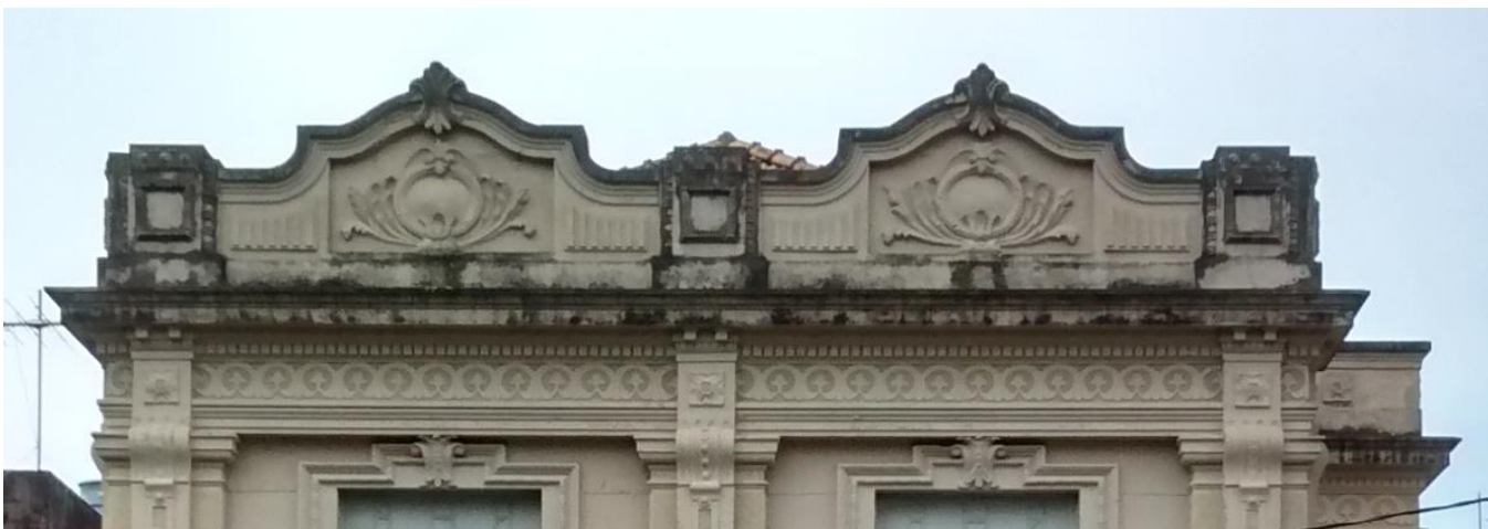
Figura 63: Frontões detalhados com frisos e relevo orgânico (as formas remetem a flores), além da forma simétrica, também a platibanda com cornijas detalhadas e as padieiras detalhadas.
