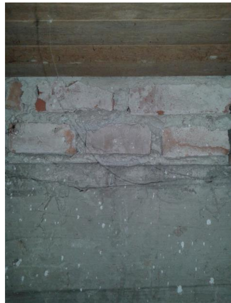
Figura 05: Alvenaria e piso de madeira Fonte: Schneider. G.(2014)
