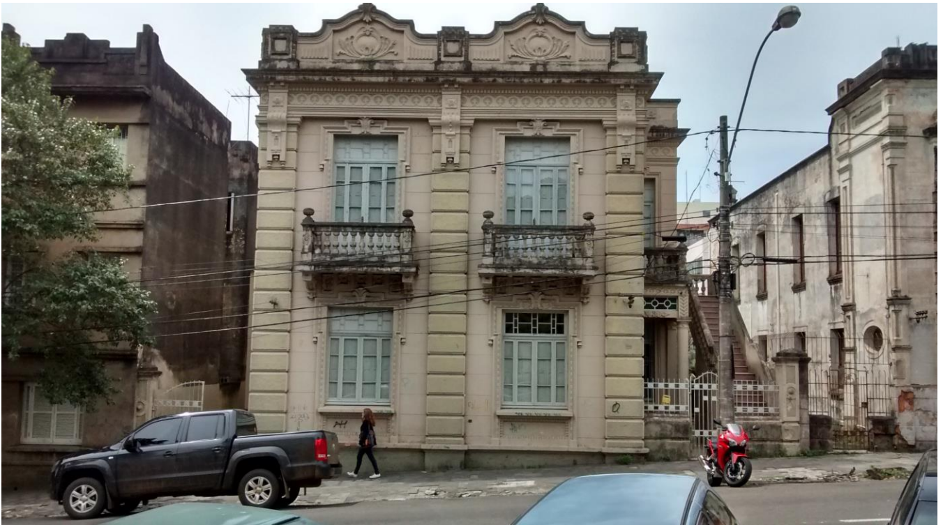
Figura 36: Fachada frontal Fonte: Schneider. G.(2014)
