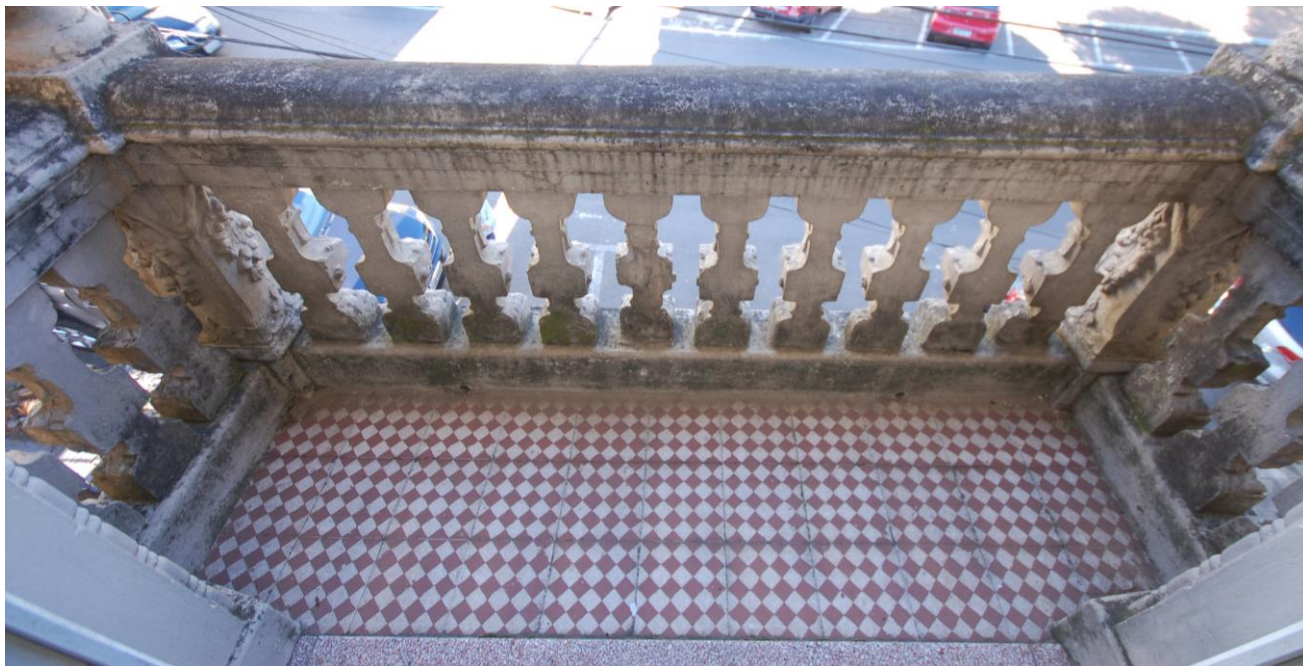
Figura 42: Sacada frontal: soleira em granitina, piso em ladrilho hidráulico e balaustrada. Fonte: Schneider, G.(2014)
