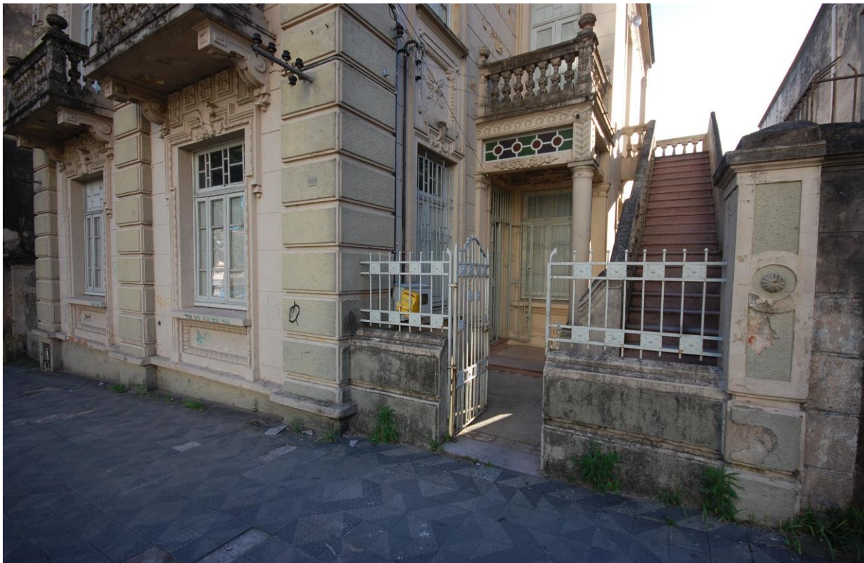
Figura 39: Acesso a edificação, juntamente com a fachada sul. Fonte: Schneider, G.(2014)
