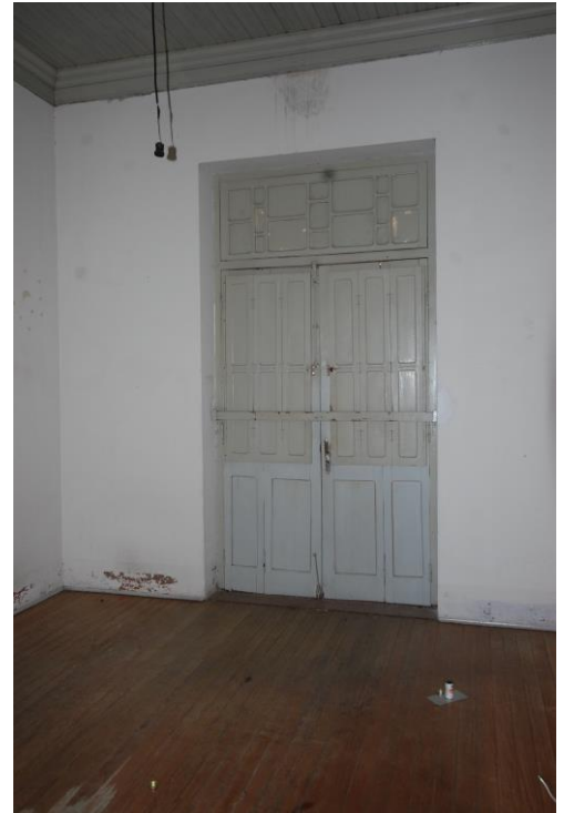
Figura 33: PSC - Porta fechada vista internamente, 2º pavimento. Fonte: Schneider, G.(2014)
