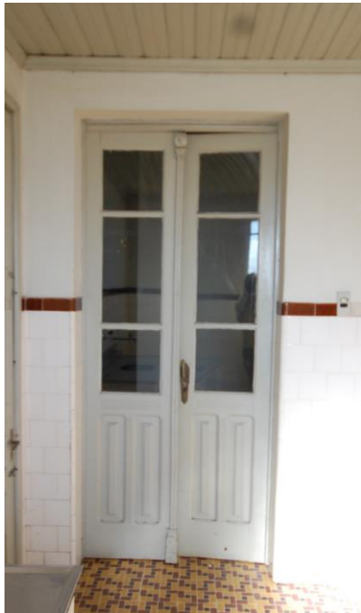
Figura 20: P09 - Porta interna, 2º pavimento. Fonte: Schneider. G.(2014)
