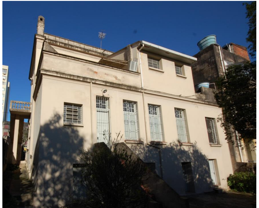
Figura 47: Fachada de fundos da edificação. Fonte: Schneider. G.(2014)
