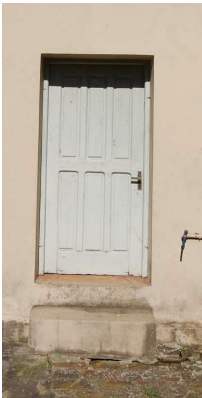
Figura 23: P12 – Porta externa e interna, subsolo. Fonte: Schneider. G.(2014)
