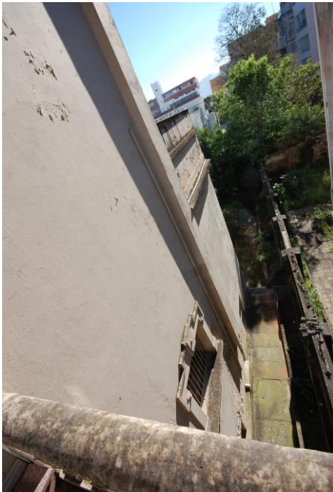
Figura 46: Fachada sul, vista do patamar do segundo pavimento, e ao fundo o pátio. Fonte: Schneider. G.(2014)
