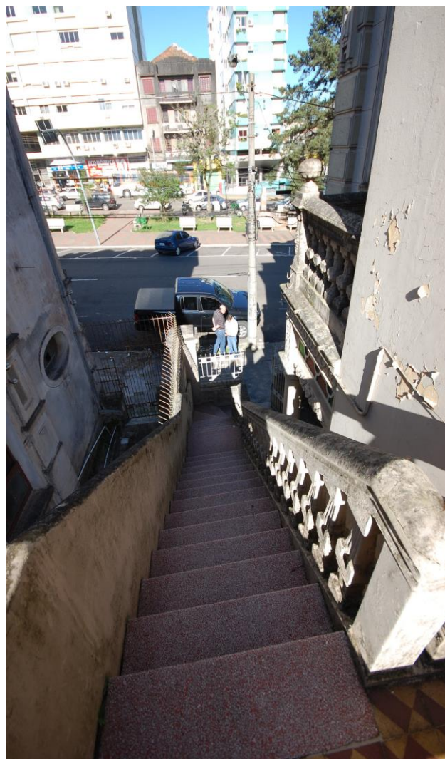
Figura 45: Escada acesso ao segundo pavimento, vista do patamar, e um trecho da fachada sul Fonte: Schneider, G.(2014)
