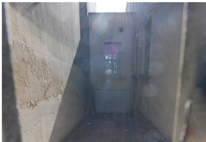
Figura 44: Fachada norte da edificação, visto direto de frente na edificação. Fonte: Schneider, G.(2014)
