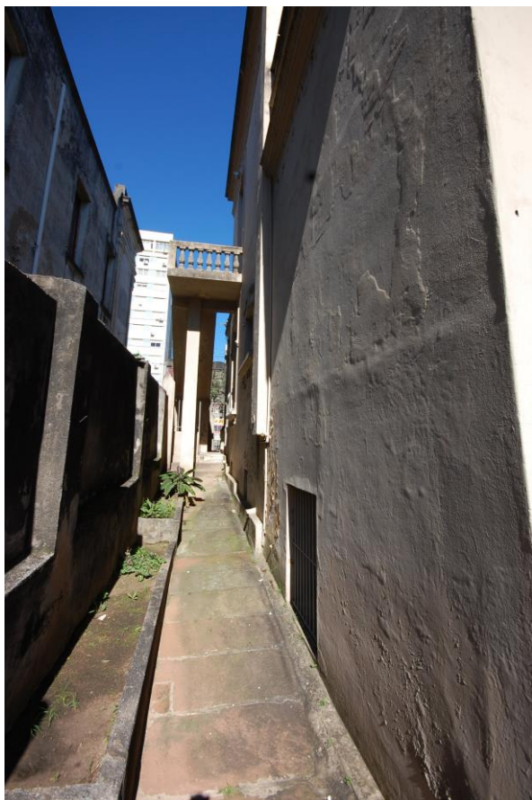
Figura 40: Lateral sul, vista dos fundos da edificação. Fonte: Schneider, G.(2014)
