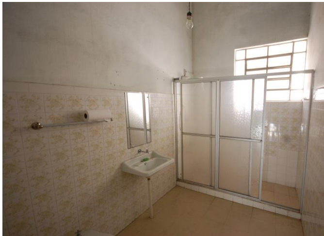
Figura 50: Sanitário do pav. térreo Fonte: Schneider, G.(2014)
