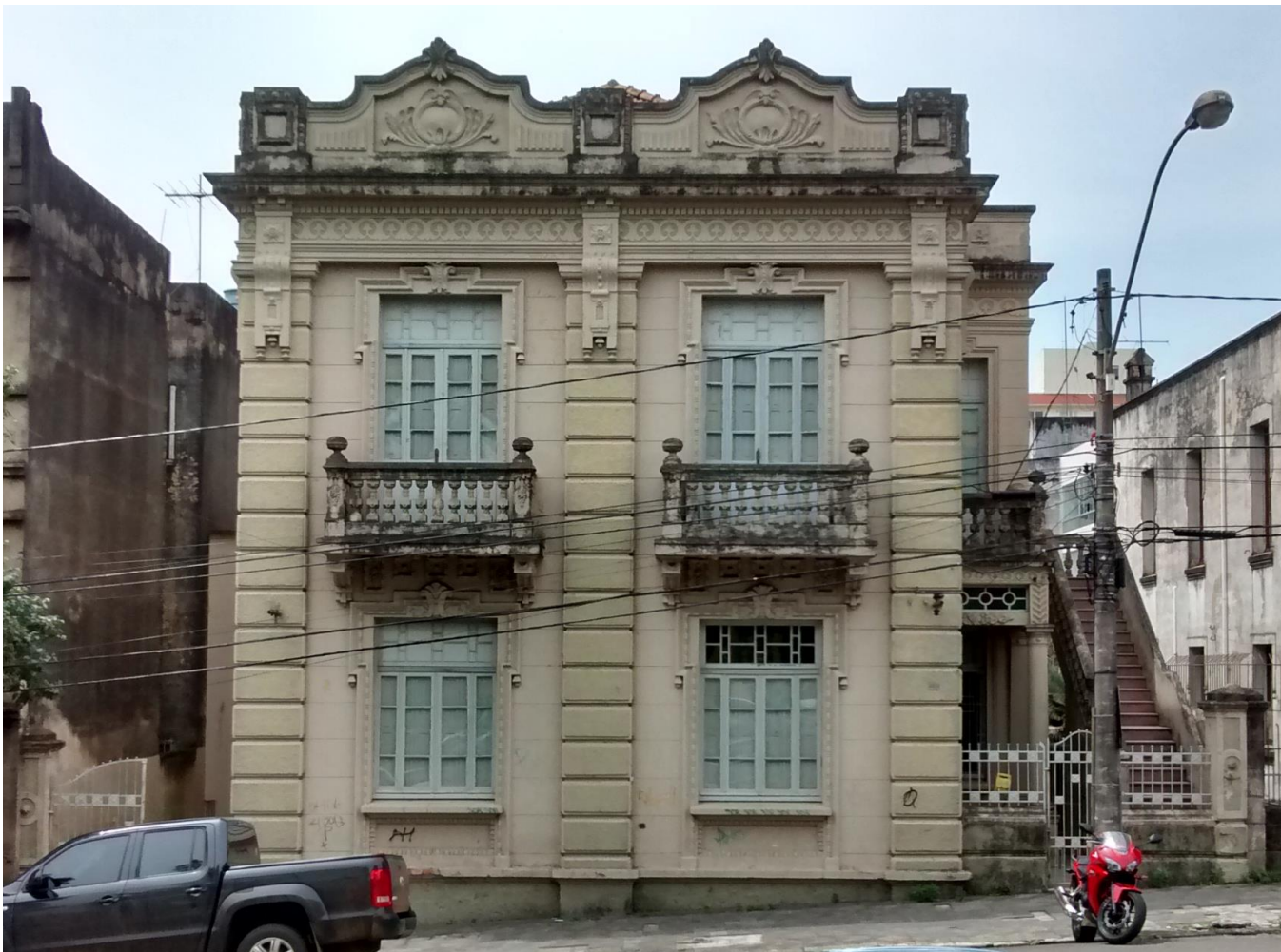
Figura 62: Fachada frontal apresentado seus detalhes arquitetônicos como: os frontões, as cornijas detalhadas e platibandas, os balcões com balaustrada, padieiras das janelas e portas, as colunas demarcadas na fachada com frisos horizontais, a alvenaria também é marcada com frisos horizontais, o acesso demarcado pela lateral juntamente com a escada, que dá acesso ao segundo pavimento, a simetria do primeiro volume.
