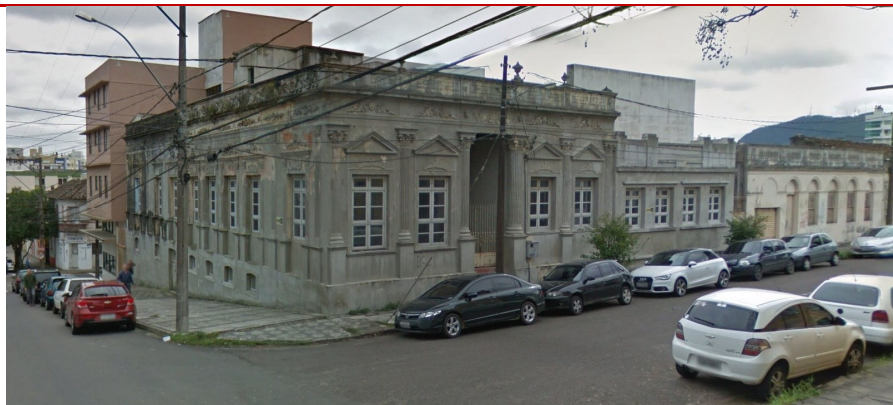
Figura 02: Fachada Leste da Edificação voltada para Rua Otávio Binato
