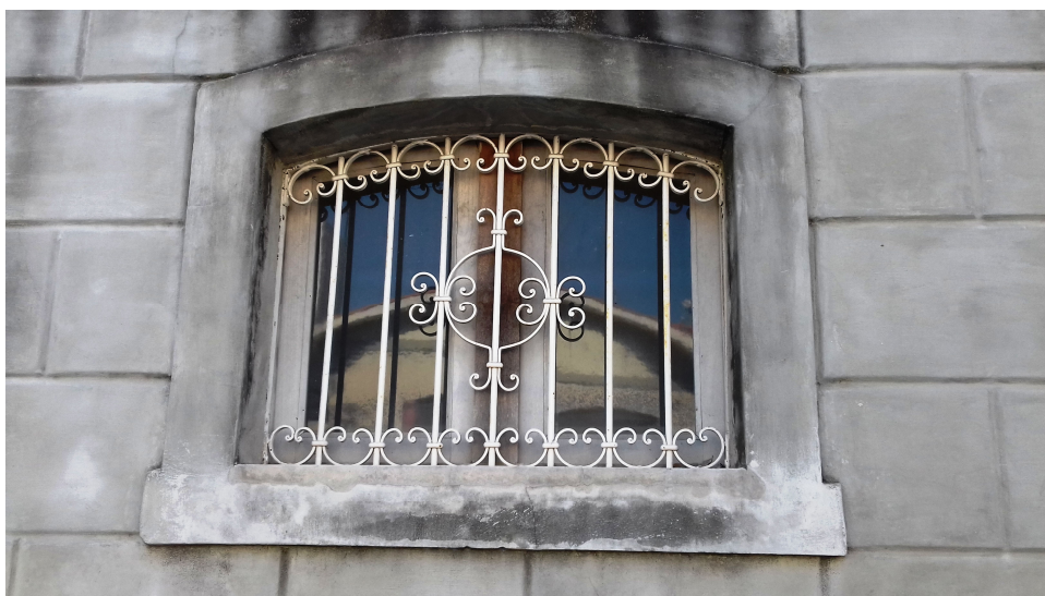
Figura 59: Janela(J04Tx6) pavimento térreo . Fonte: Ludtke, Elke. (2017)
