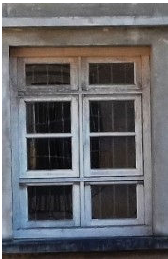
Figura 57: Janela (J02Sx4) pavimento superior. Fonte: Ludtke, Elke. (2017)
