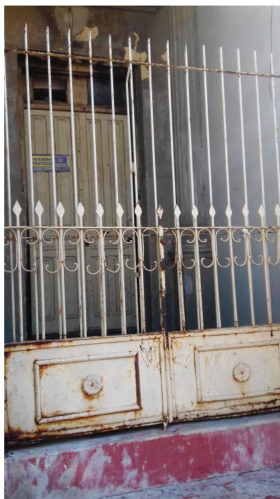
Figura 61: Portão de ferro com muitos focos de ferrugem . Fonte: Ludtke, Elke. (2017)
