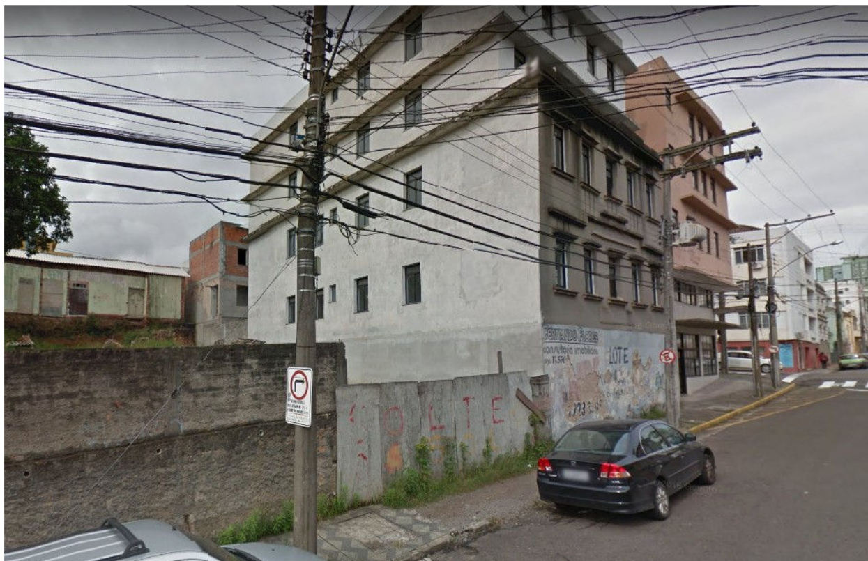
Figura 37: Acesso à edificação Rua Floriano Peixoto (Fundos) - Modificações existentes. Fonte: Ludtke, Elke (2017)
