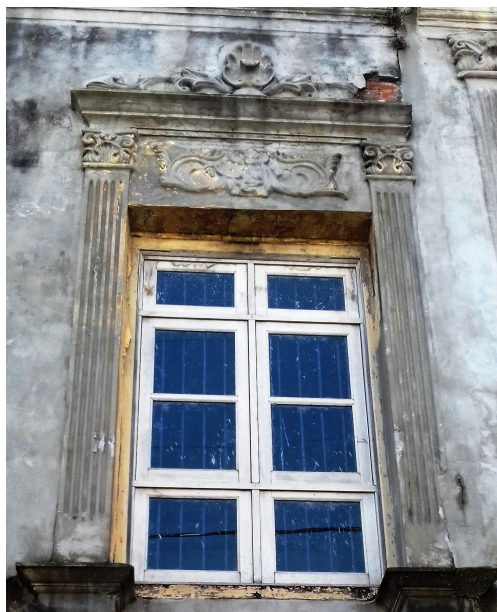
Figura 56: Janela (J01Sx12) pavimento superior. Fonte: Ludtke, Elke. (2017)
