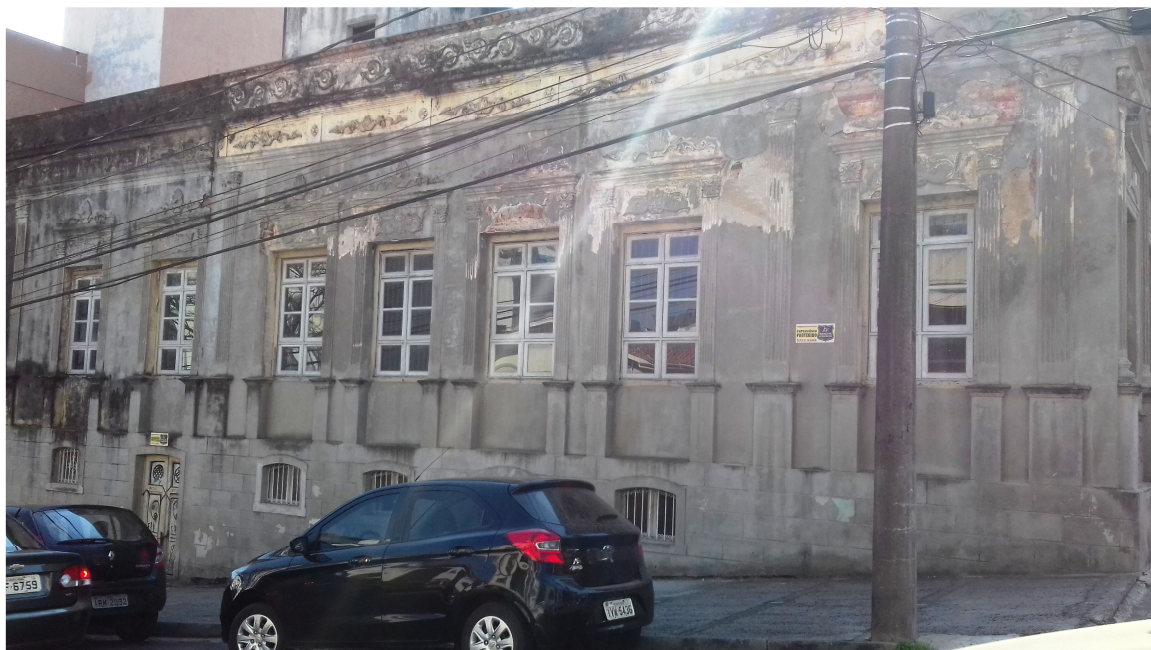
Figura 31: Vista fachada Lateral (Sul) – Rua Vale Machado. Fonte: Ludtke, Elke. (2017)
