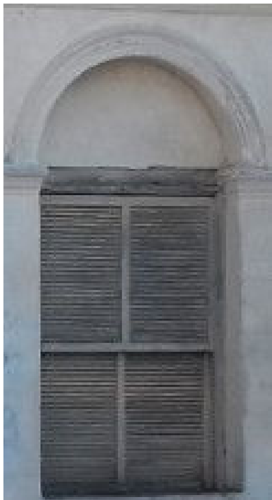
Figura 58: Janela (J03Sx4) pavimento superior . Fonte: Ludtke, Elke. (2017)
