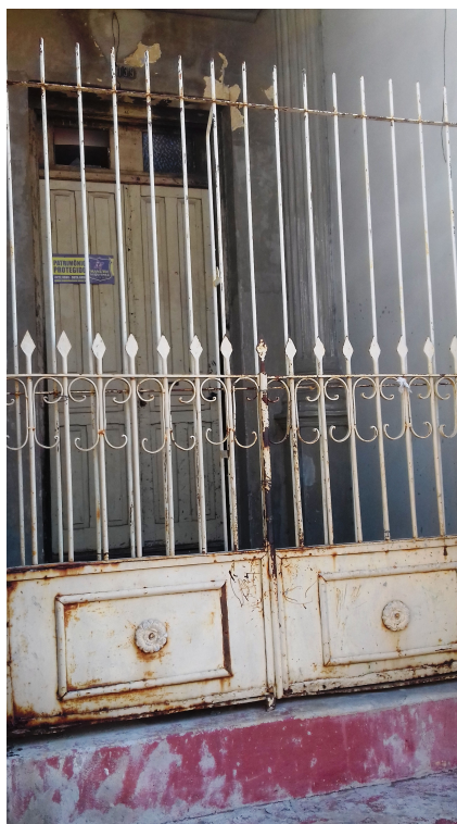
Figura 34: Acesso à edificação Rua Otávio Binato – Portão de Ferro Fonte: Ludtke, Elke (2017)
