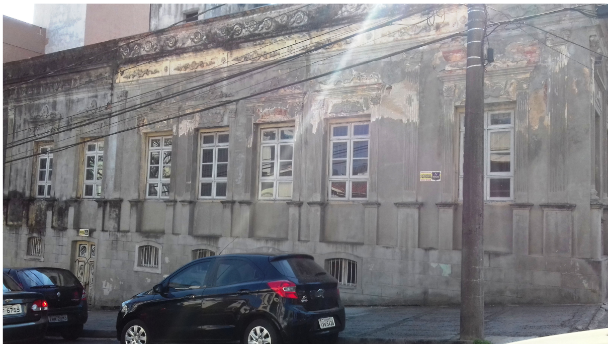
Figura 35: Acesso à edificação Rua Vale Machado. Fonte: Ludtke, Elke (2017)
