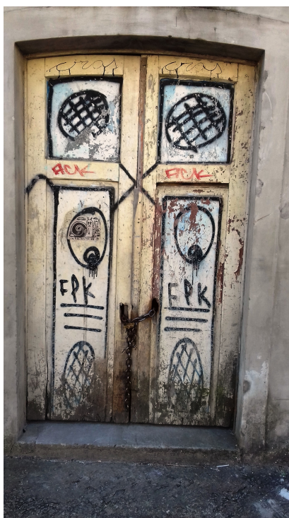
Figura 55: Porta (P03Tx1) pavimento térreo. Fonte: Ludtke, Elke. (2017)
