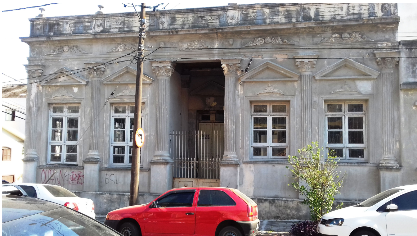
Figura 33: Acesso à edificação Rua Otávio Binato. Fonte: Ludtke, Elke (2017)
