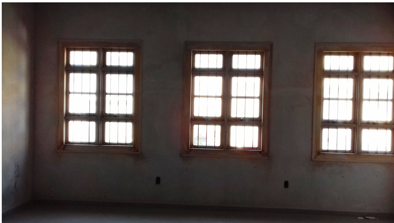
Figura 40: Vista interna Salão Pav. Superior – Rua Otávio Binato Fonte: Ludtke, Elke. (2017)
