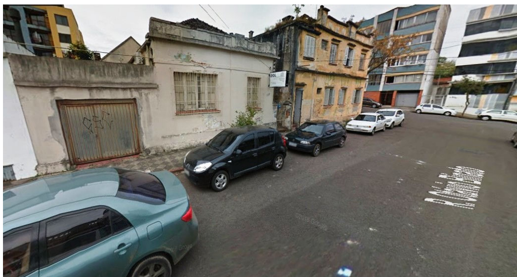
Figura 28: Edificações à frente sentido - oeste . Fonte: Maps Google 2017.
