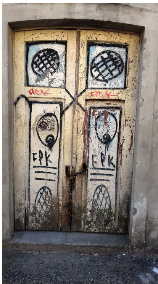
Figura 36: Acesso à edificação Rua Vale Machado – Porta de Madeira. Fonte: Ludtke, Elke (2017)
