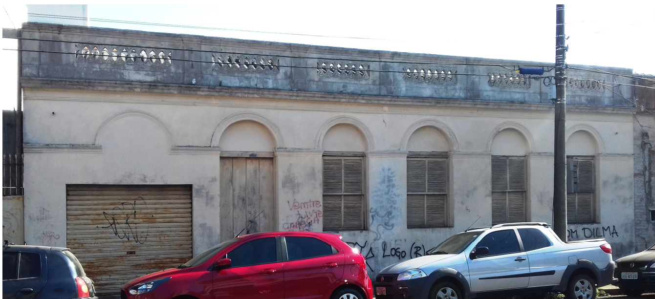
Figura 50: Fachada Rua Otávio Binato em sequência a imagem anterior, percebendo-se a diferença de estilo arquitetônico Fonte: Ludtke, Elke. (2017)
