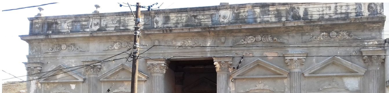
Figura 48: Detalhes do entablamento da Fachada Rua Otávio Binato. Fonte: Ludtke, Elke. (2017)
