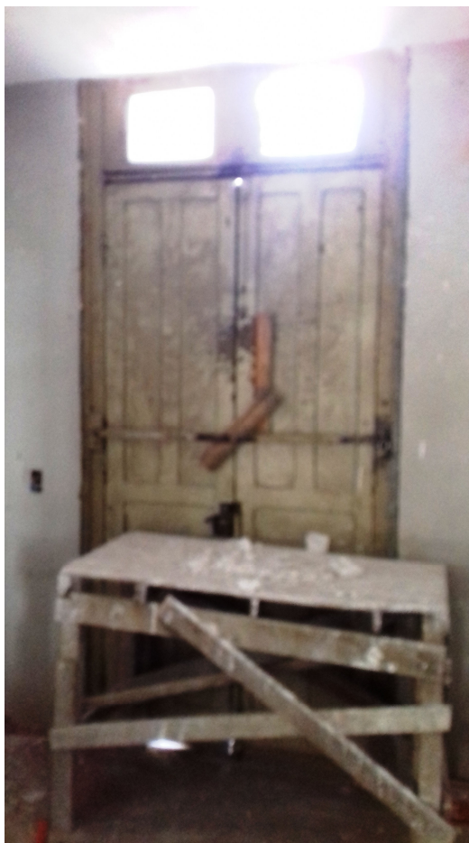
Figura 52: Porta de acesso principal (P01Sx1) pavimento superior. Fonte: Ludtke, Elke. (2017)
