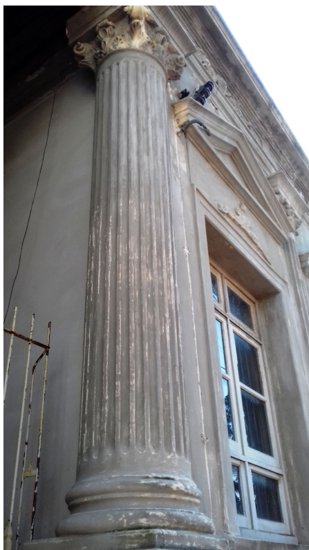
Figura 46: Detalhes coluna coríntia finalizada pelo entablamento. Fonte: Ludtke, Elke. (2017)
