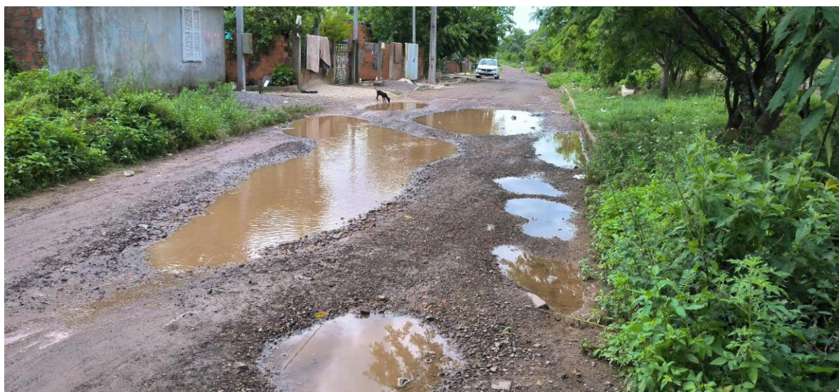
Figura 18 - Ruas sem pavimento com pouca manutenção e problemas de drenagem pluvial geram alagamentos na Vila Km 3.
