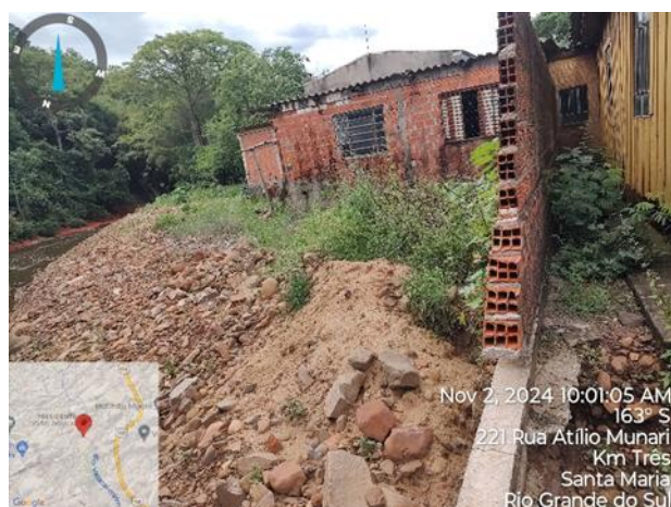
Figura 32 - Vista parcial do Setor S52. Erosão de margem do rio Vacacaí-Mirim.
