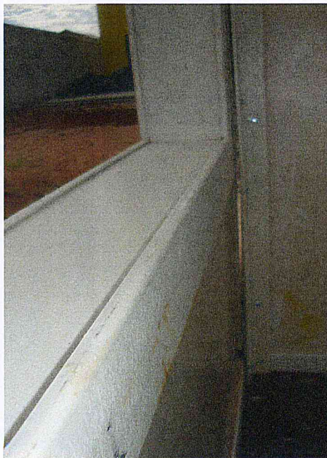
Foto 11 – Prumo no encontro de painéis
