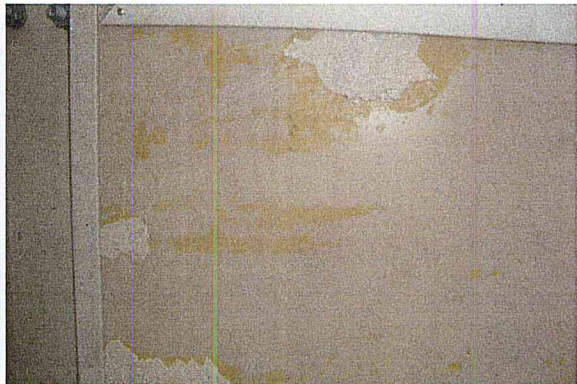
Foto 10 – Remendo painéis
